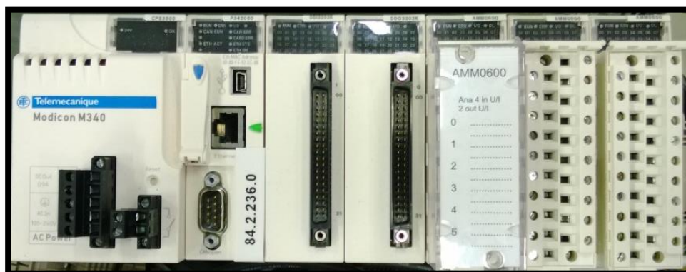
KUVA 8. Moduulit asennettuna räkkiin
