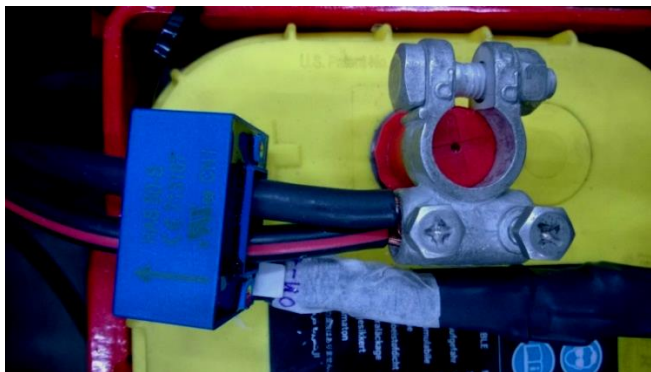
KUVA 18. HAS 50-S -mittamuuntaja käyttöakun päällä
