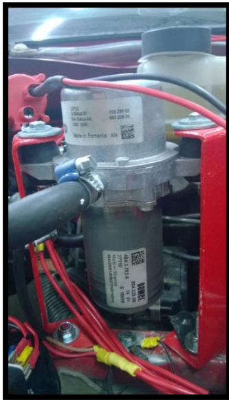
KUVA 26. Alipainepumppu ja taustalla punainen alipaineanturi
