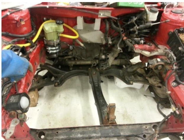
KUVA 2. Moottoritila purettuna ja sähköinen hydraulipumppu asennettuna
