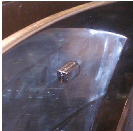
Kuva 3. Kattilan sisäpintaan hitsattu täyttöastemerkki.
