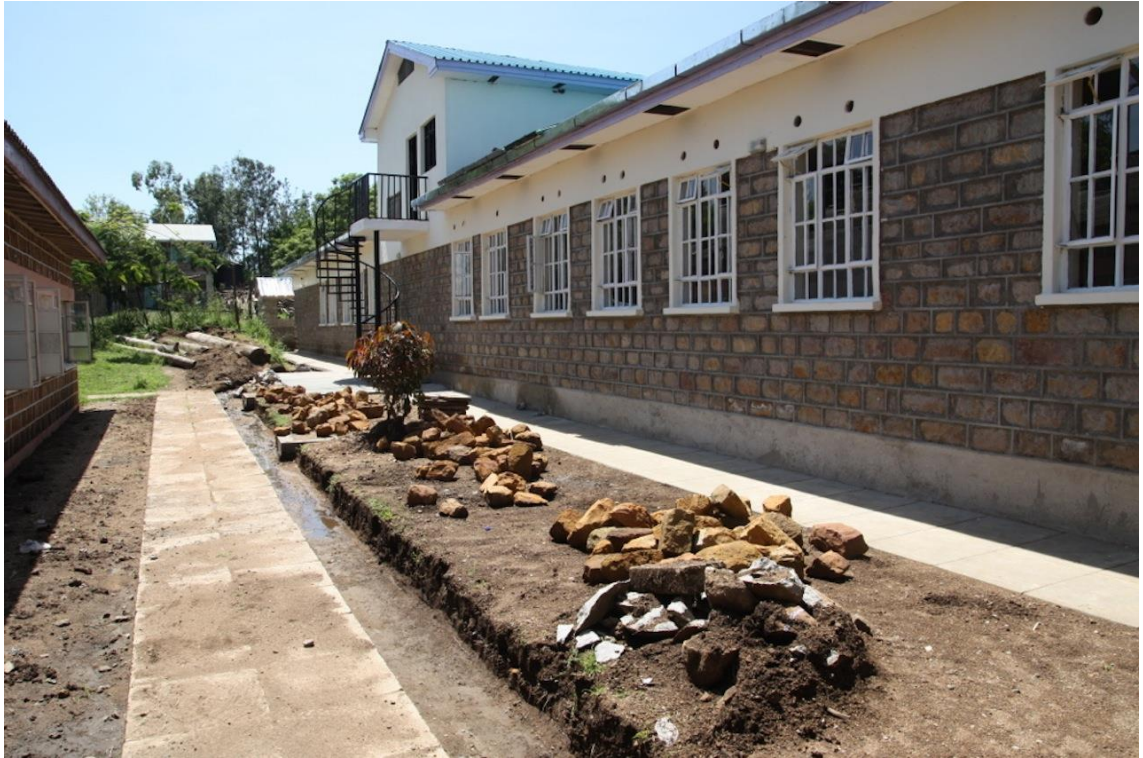
Kuva 2. Uuden rakennetun leikkaussaliosaston takapiha.
