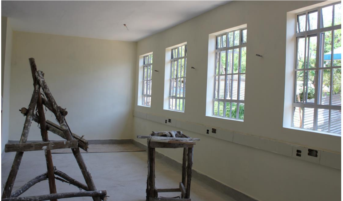
Kuva 9. Rakenteilla olevan heräämötilan pintakäsittelyä.
