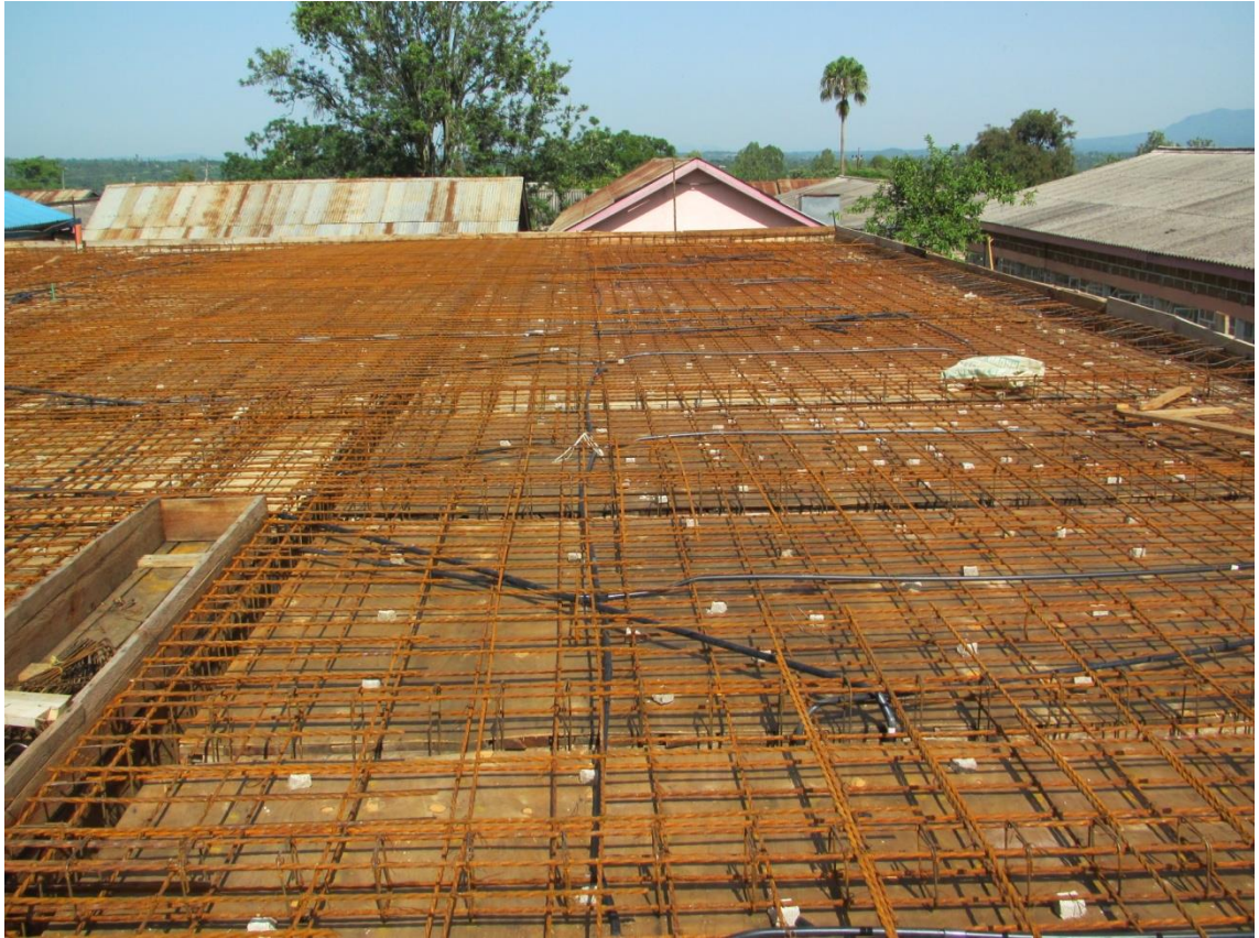
Kuva 11. Sähköputkitusta ennen toisen kerroksen lattian valua.
