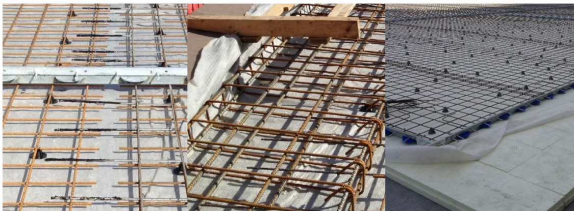
Kuva 14. Pysäköintikannen raudoitus. Kuva Ville Väisänen
