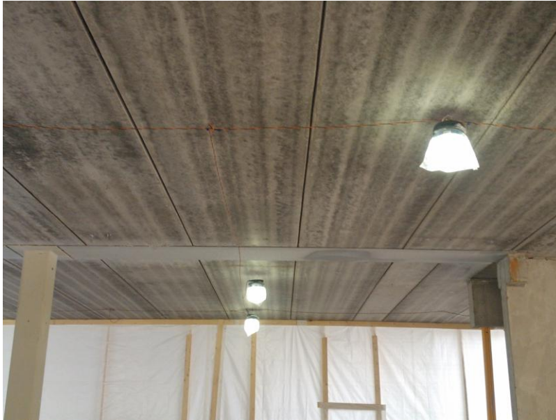
Kuva 2. Uusia LED-valaisimia kiinnitettynä holviin.
