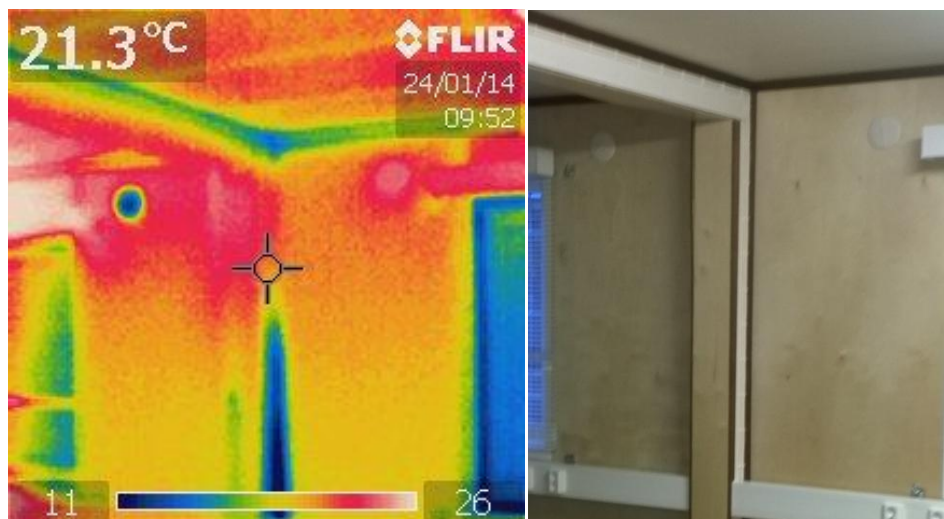
Kuva 11. Uuden parakin liitoskohta sekä ilmanvaihtoaukot seinässä.
