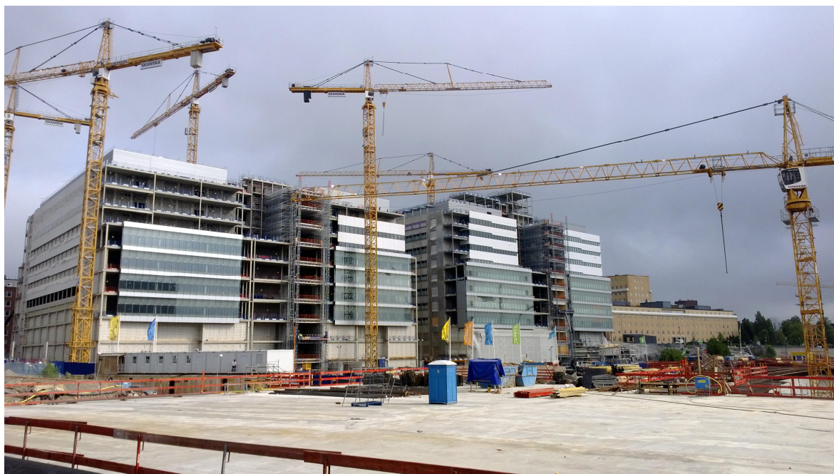
Figur 10: Studiebesök på NKS byggarbetsplats 23.5.2013 © Torbjörn Brusas
