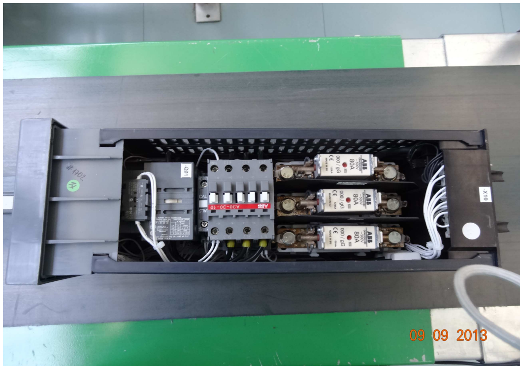
Kuva 12. Suora lähtö, jossa sulakkeet, katkaisija, kontaktori ja pääkytkin. Lähdön nimellisvirta 29A.
