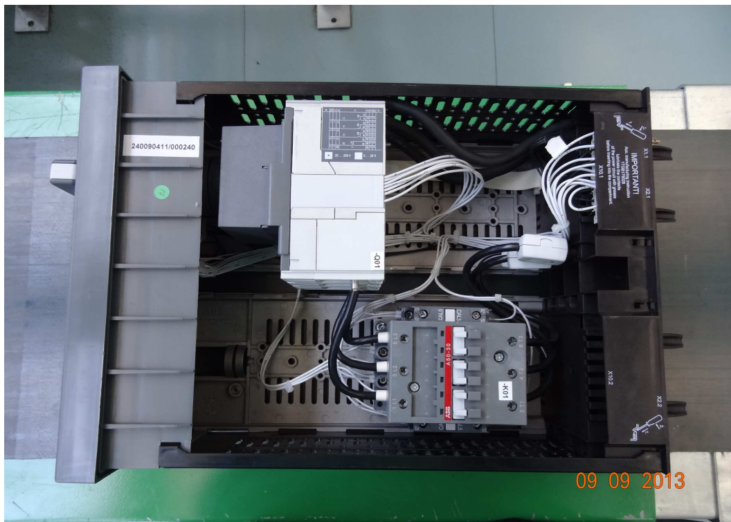
Kuva 13. Suora lähtö, jossa katkaisija, kontaktori ja pääkytkin. Lähdön nimellisvirta 41A.
