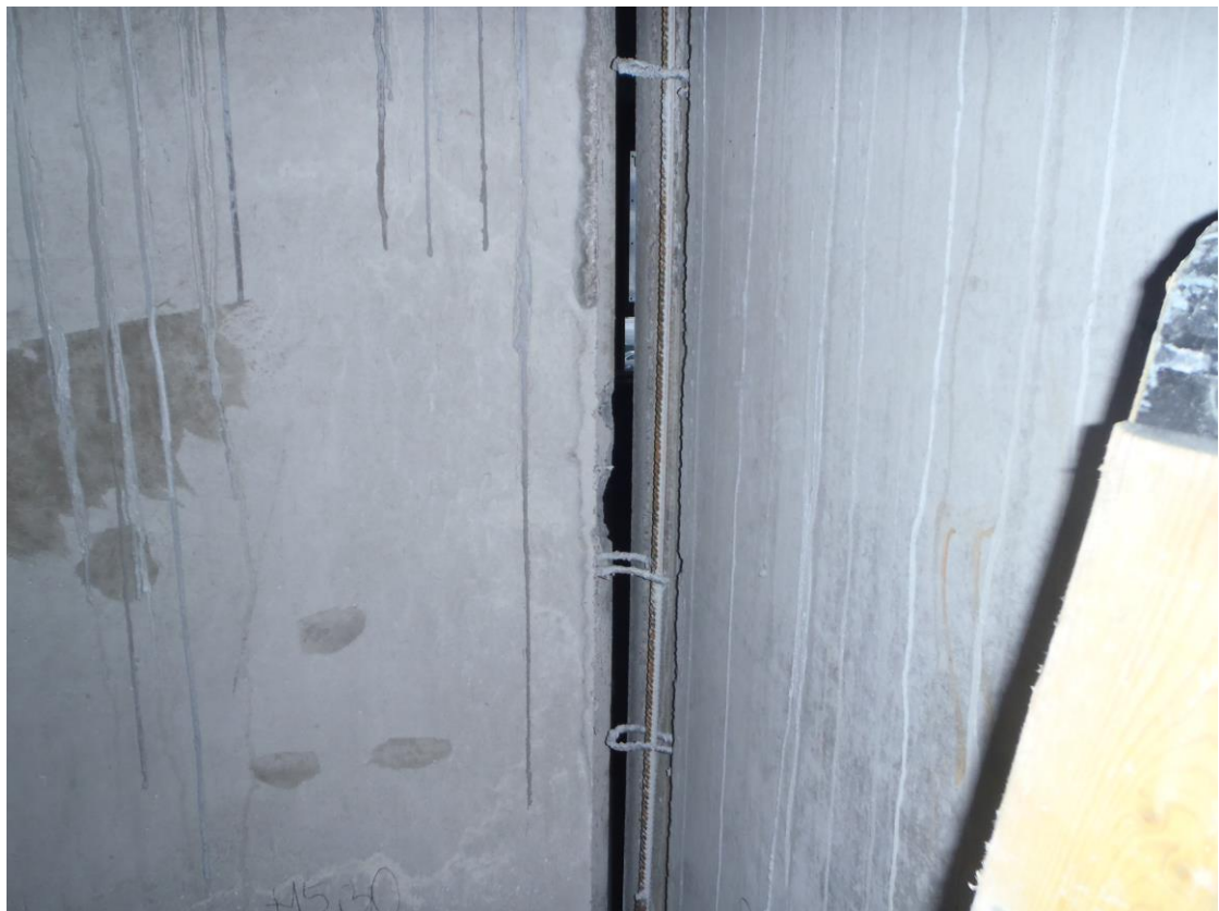
Kuva 6. Väliseinäelementtien pystysauma raudoitettuna (Kuva: Aatu Pajunen)
