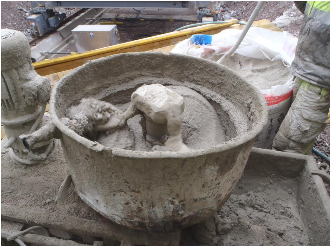
Kuva 4. Saumabetonin pumppaamiseen käytettävä pumppuasema (Kuva: Aatu Pajunen)
