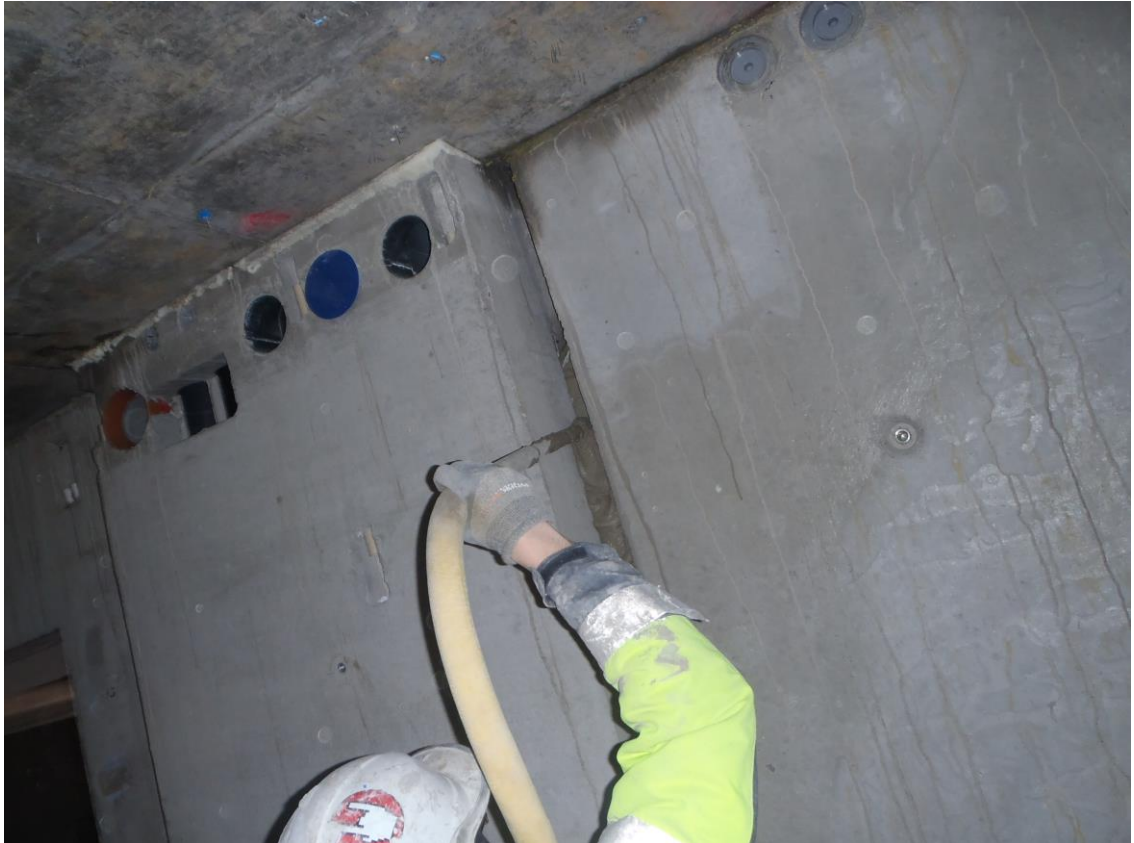
Kuva 5. Pumppaustyö; letku pumpattavan betonin sisällä (Kuva: Aatu Pajunen)
