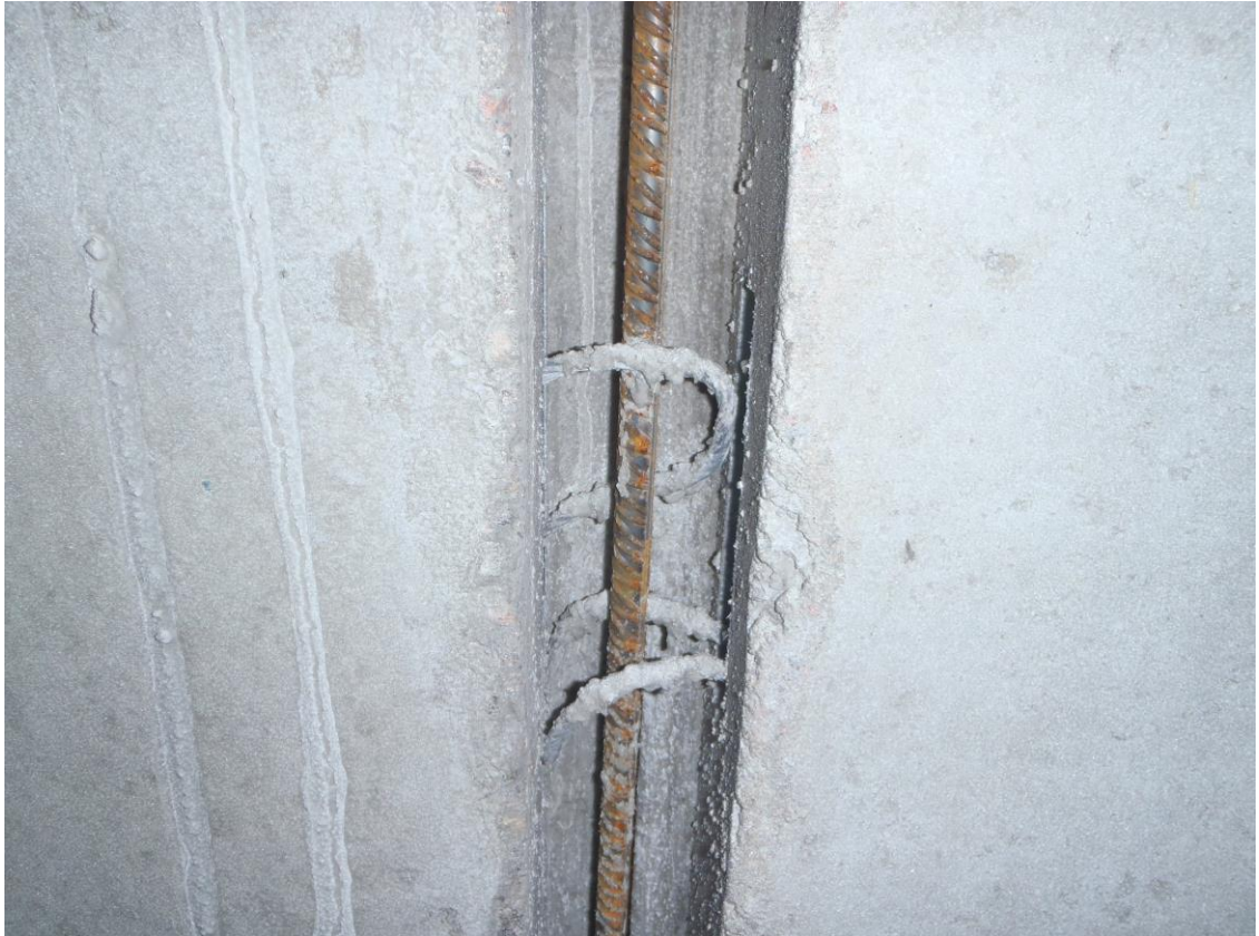
Kuva 10. Pystysauman raudoitus; pystytanko ja vaijerilenkit (Kuva: Aatu Pajunen)
