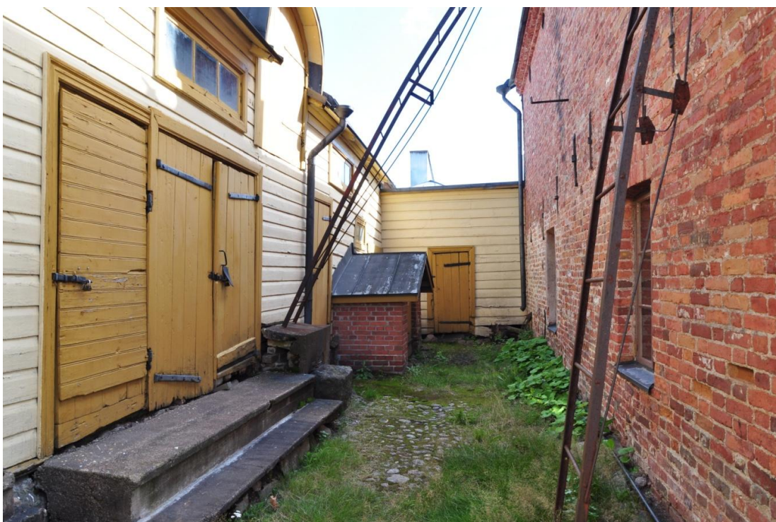
Kuva 7. Varastorakennukset ja kellarin sisäänkäynti. Kuvassa oikealla Pajarakennus.
