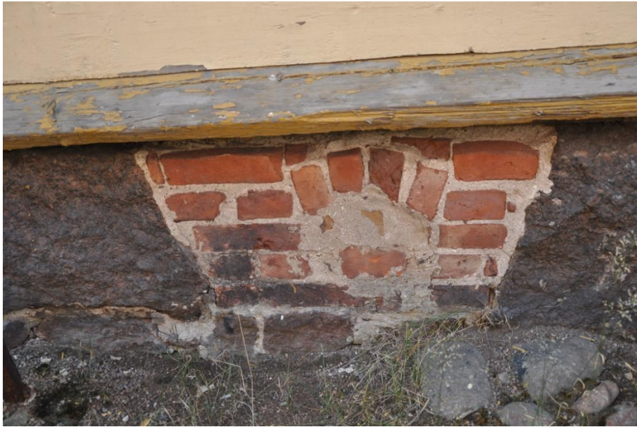
Kuva 19. Mattilan umpeen muurattu tuuletusaukko
