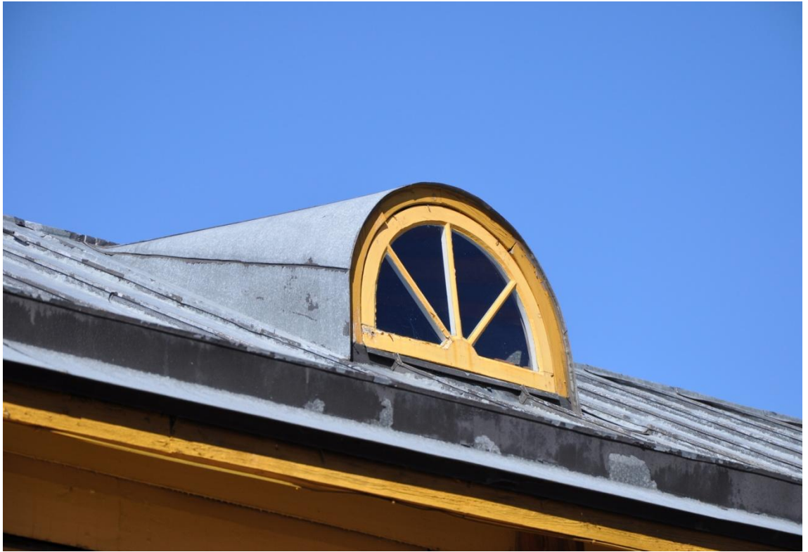
Kuva 17. Ajurin asunnon kattoikkuna
