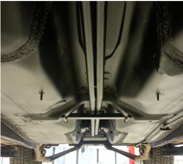
KUVA 43. Pakoputkin tilalla asemmetut päävirtakaapeleiden putket
