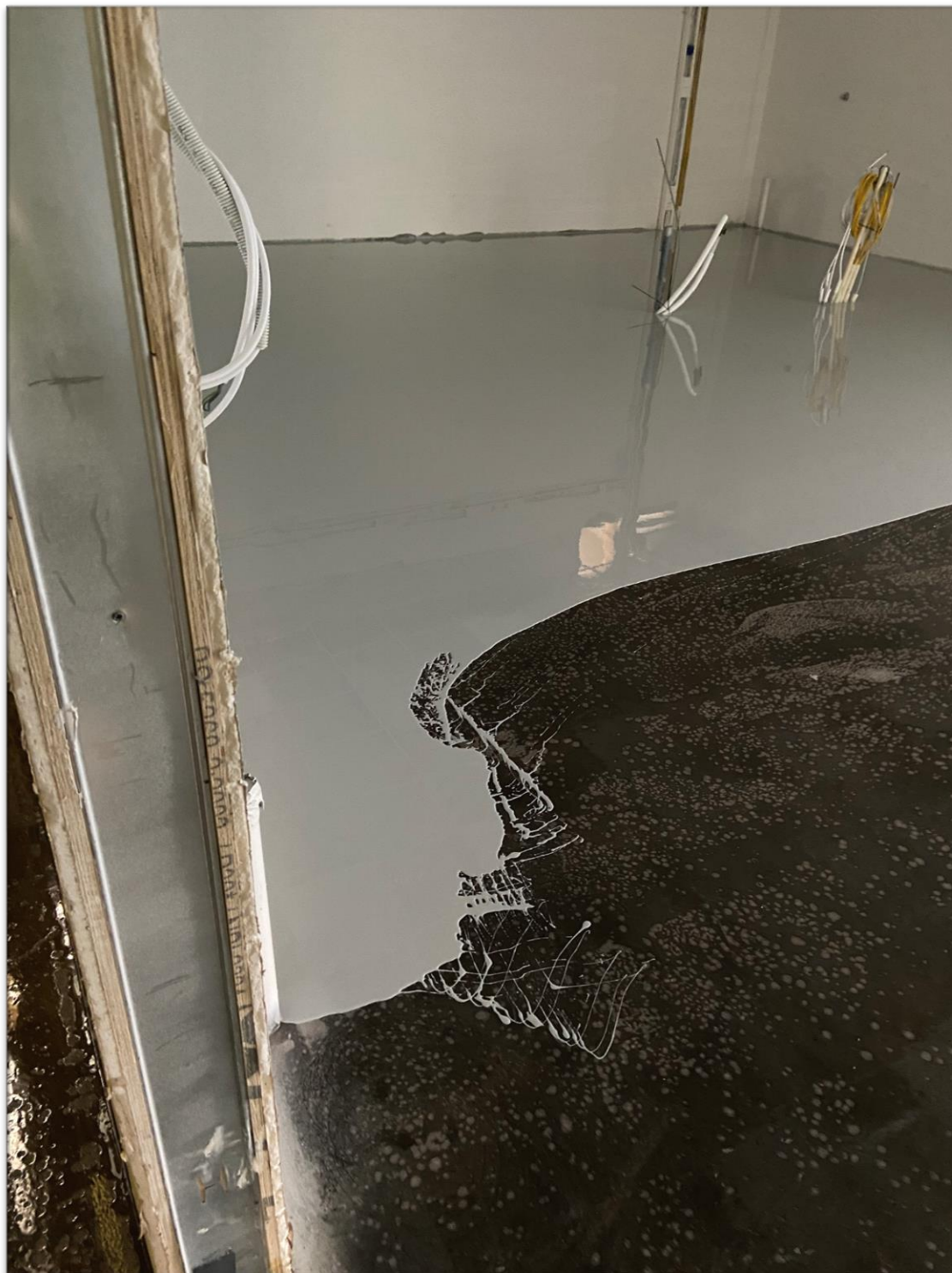
Kuva 3. Mastertop 1325 Polyuretaanipinnoitejärjestelmän runkomassan levitys pohjusteen päälle. (Anssi Yppäriä 2021)
