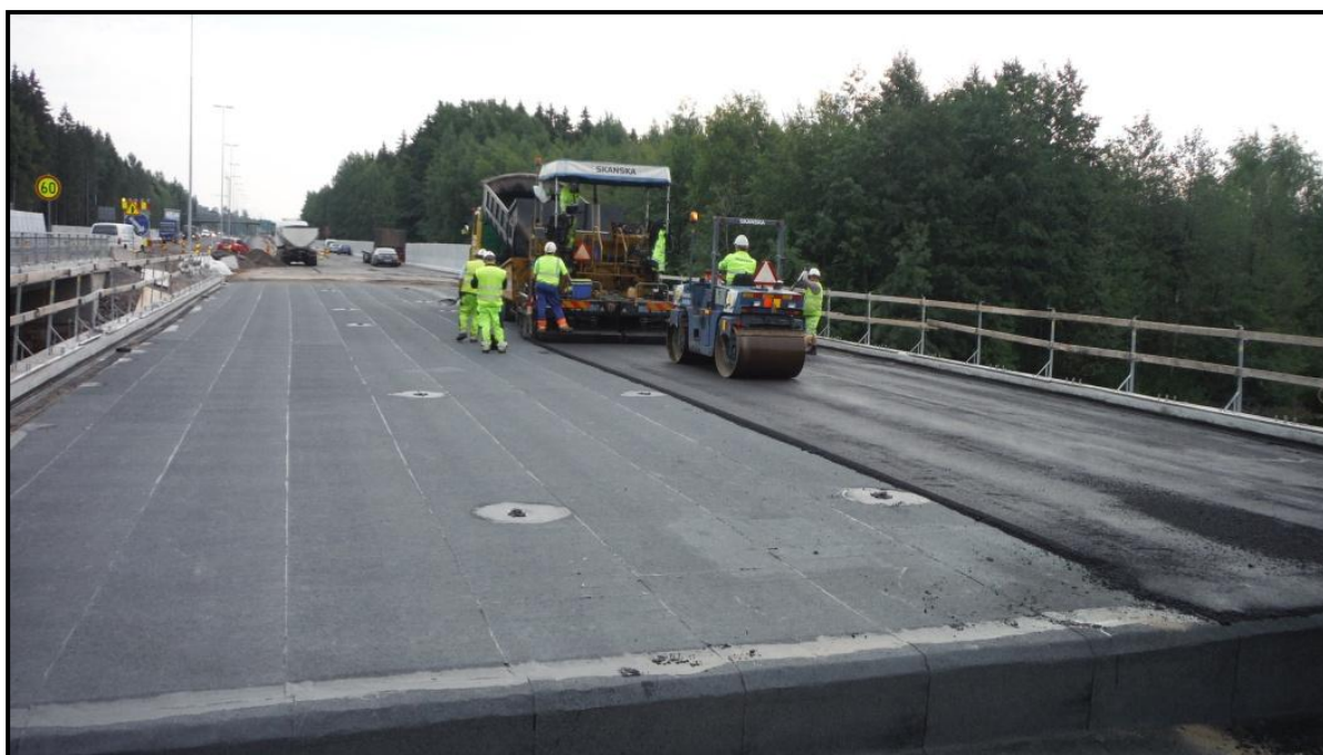
KUVA 48. Sillan kannen Asfaltointi (Tarvainen 2013-08-19)
