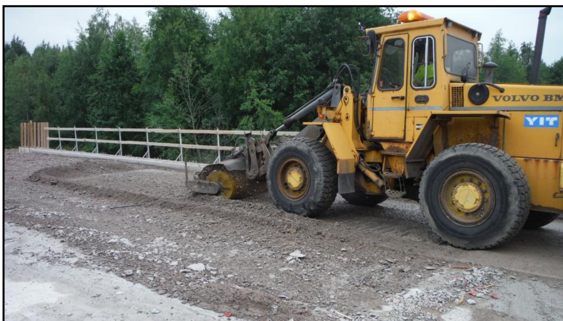
KUVA 38. Vesipiikkauksen jälkeen kansi puhdistettiin harjakoneella (Tarvainen 2013-07-25)
