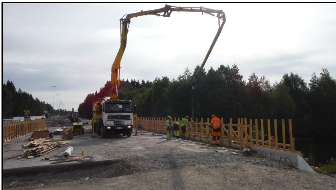
KUVA 29. Reunapalkin betonointityö käynnissä (Tarvainen 2013-07-18)
