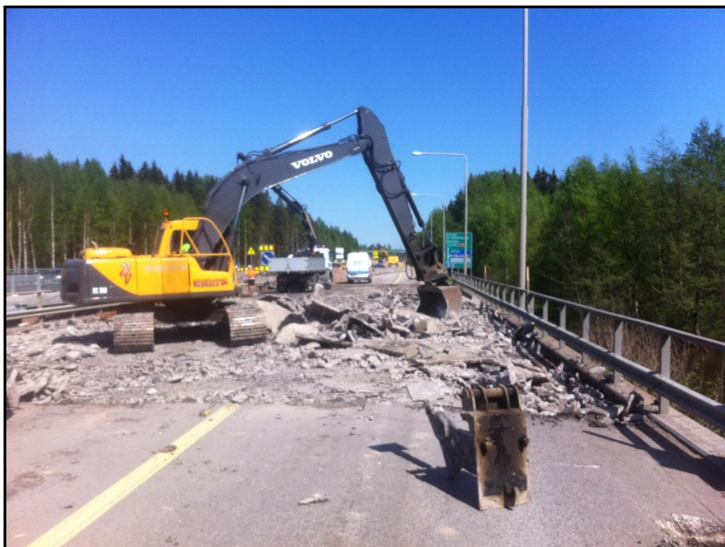
KUVA 5. Pintarakenteiden poistoa kaivinkoneella (Tarvainen 2013-05-21)
