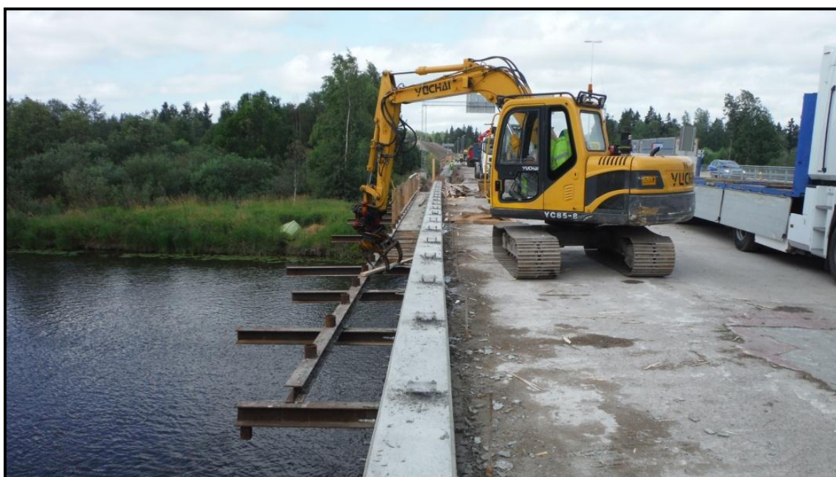
KUVA 32. Telineiden purkamista kaivinkoneella (Tarvainen 2013-07-23)
