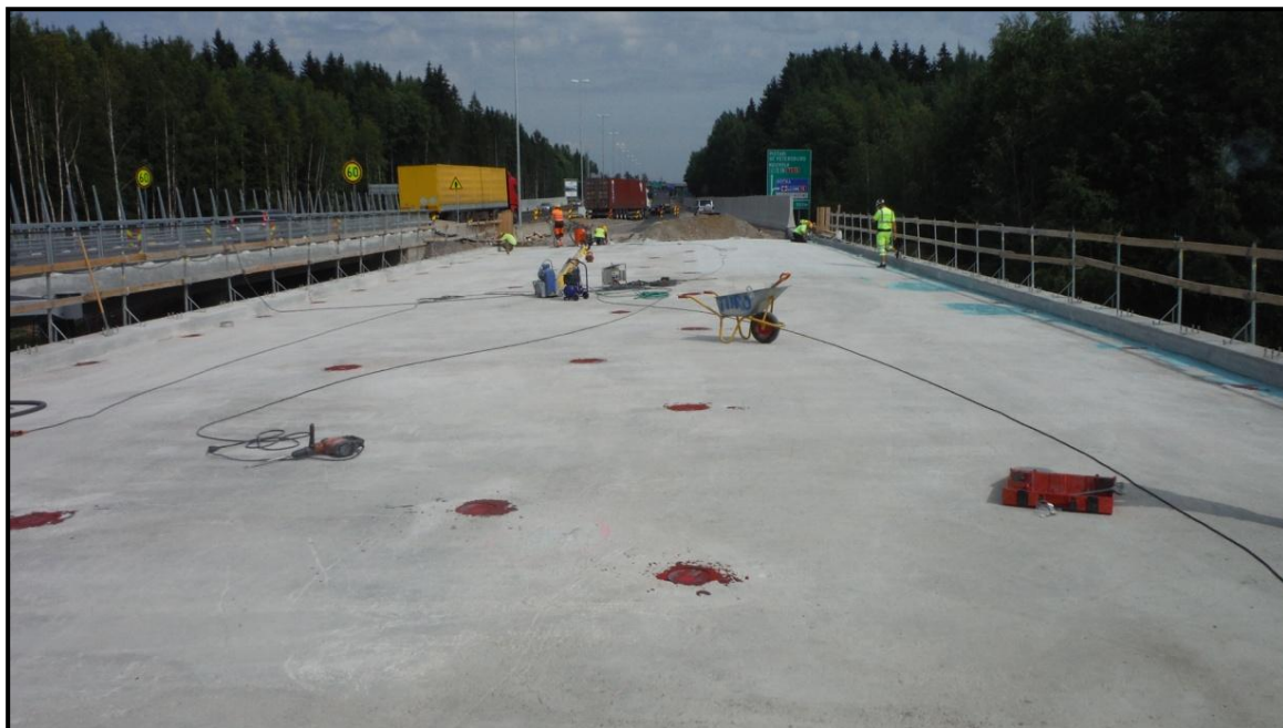
KUVA 43. Pintavesiputkien, tippuputkien ja reunakaatojen tekoa epoksilla (Tarvainen 2013-08-06)
