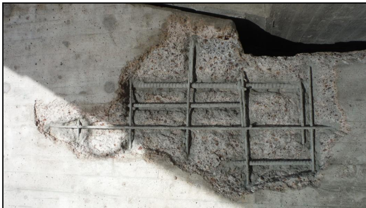
KUVA 15. Etumuurin korjaus. Raudoitus StoCrete THP korroosiosuojalaasti käsittelyn jälkeen (Taruainen 2013-08-28)
