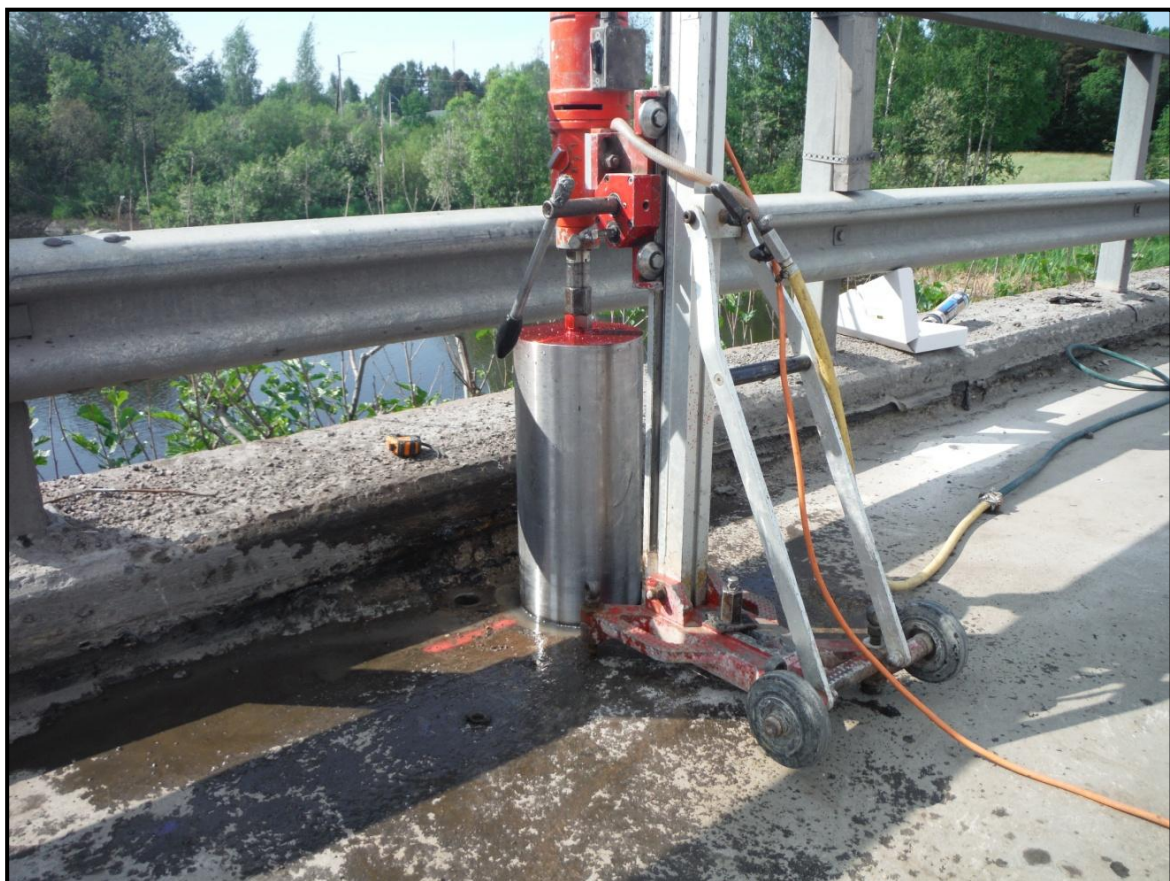
KUVA 14. Pintavesiputkien porausta timanttiporalla (Tarvainen 2013-06-04)
