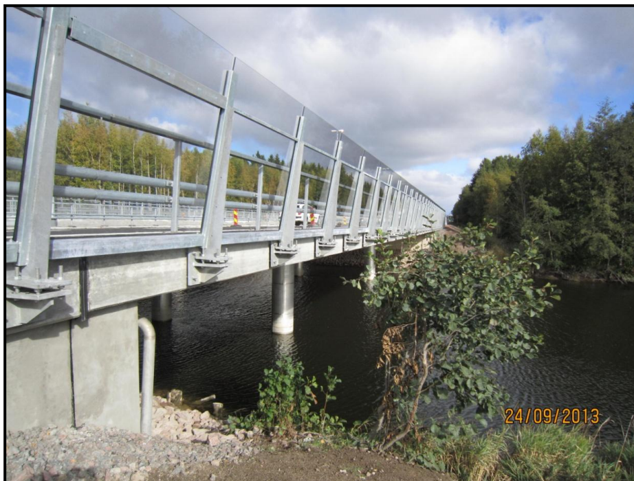
KUVA 51. Valmis meluseinä. (Laamanen 2013-09-24)
