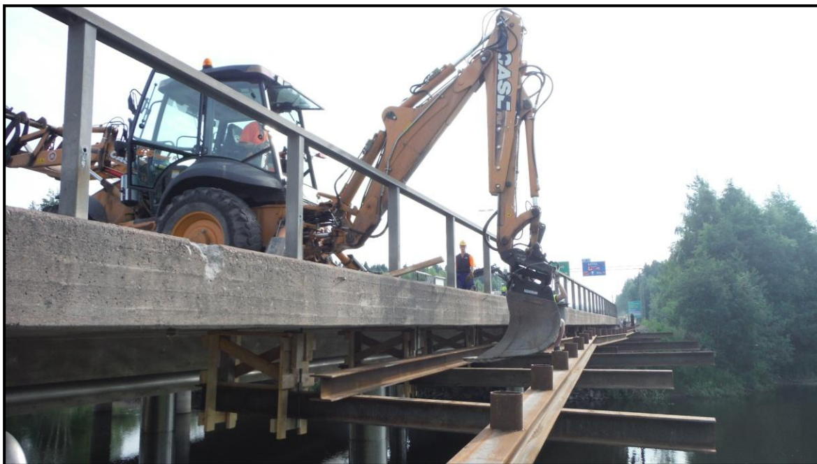
KUVA 21. Teräspalkkien asettelussa käytettiin traktorikaivuria (Tarvainen 2013-06-10)
