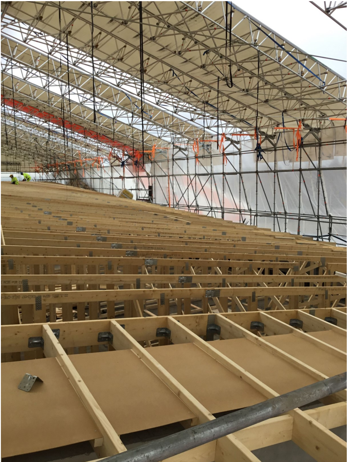
Figur 6 Vattentaket och väderskyddet, takkonstruktionernas skydd kan vid behov öppnas. (Sillman, 2021)
