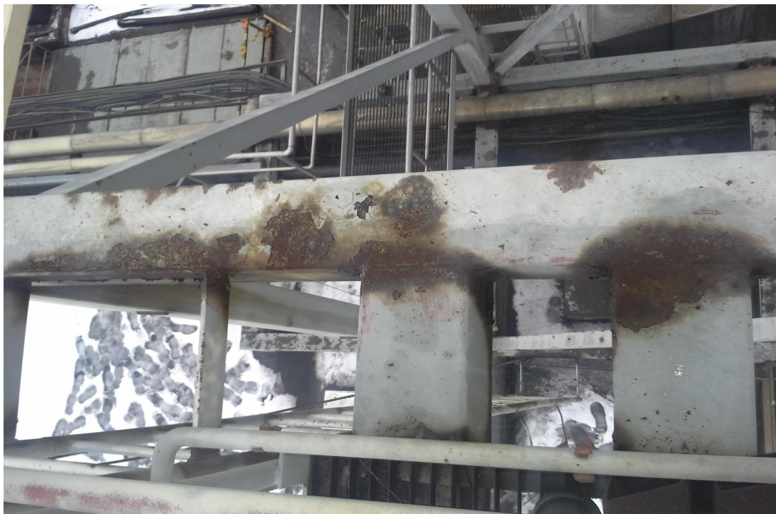
Kuva 34. Puutteellinen pintakäsittely hitsauksen jälkeen (kuva: Jari Saarinen)
