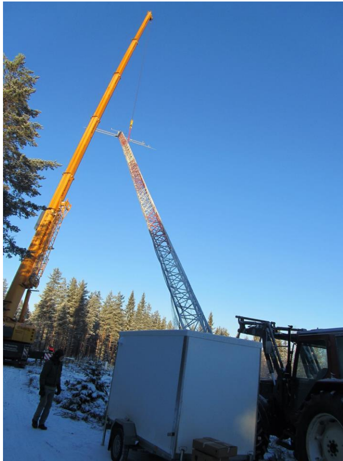
Kuva 22. Maston nosto-operaatio.
