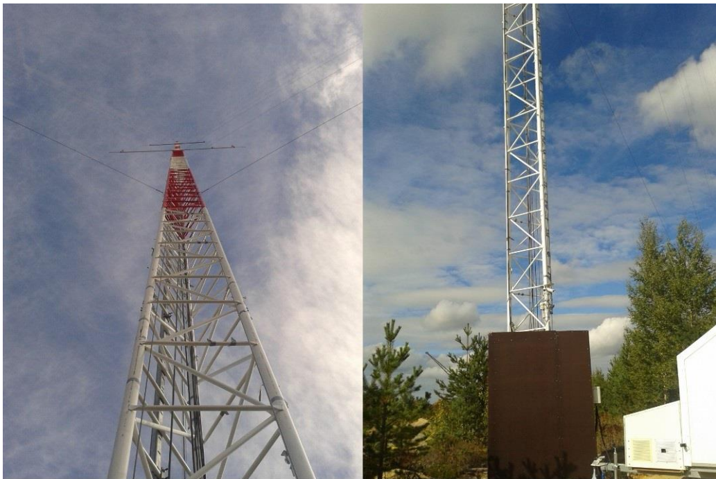
Kuva 3. Kapasystems Ky:n 120 metrin ristikkomasto.
