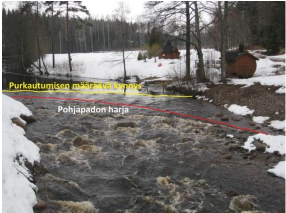
KUVA 25. Turpaan pohjapato tulva-aikana huhtikuussa v. 2013 (Laine 2013)
