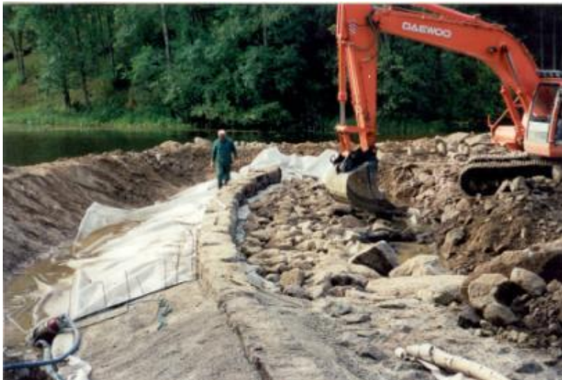
KUVA 8. Jokelan pohjapadon rakentamista työpadon suojassa (Leppikangas 1999)
