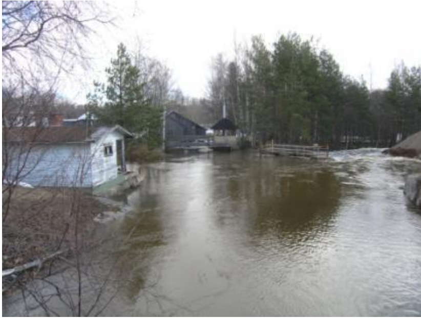
KUVA 10. Reinikkalan säännöstelypato tulvauomineen (Tapaninen 2005)
