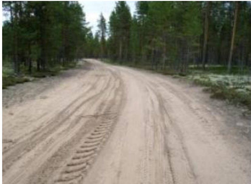
KUVA 8. Tie kestäisi maaperän puolesta myös kelirikon aikaisen kuljetuksen, mutta kulutuskerroksen hienojakoisuus estää puutavaran kuljetuksen ainakin sateisena aikana (Metsäteho 2008a)
