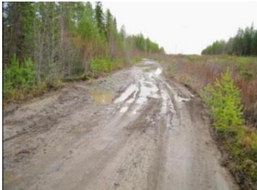
KUVA 7. Tie kestää ehkä kesällä kuivaan aikaan tapahtuvan puutavaran kuljetuksen. Tämän näköisillä teillä kannattaa aina tarkistaa kääntöpaikka (Metsäteho 2008a)
