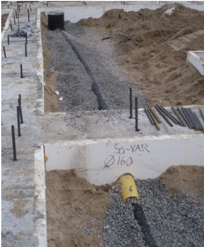
Kuva 3. Salaojaputki, salaojakaivo ja salaojamursketta asennettuina talon pohjarakenteisiin. [9]
