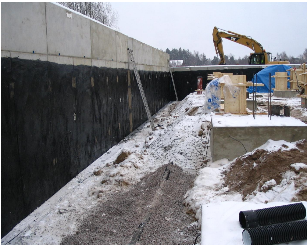
Kuva 3. Bitumisivelyllä kosteuseristetty maanvastainen seinä [9].
