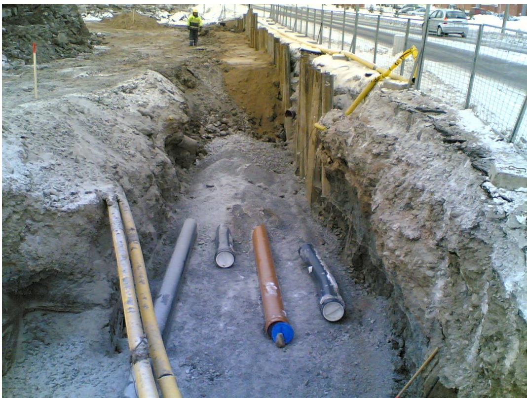
Kuva 1. Putkikaivanto, jonka toinen puoli on tuettu ponttiseinällä (oikealla) ja toinen puoli on luiskattu (vasemmalla) [9].
