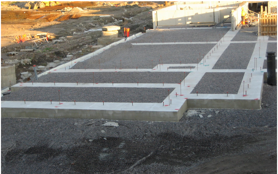
Kuva 5. Kuvassa näkyy valmis raaluantura ja valmiit kapillaarikatkon täytöt [9].
