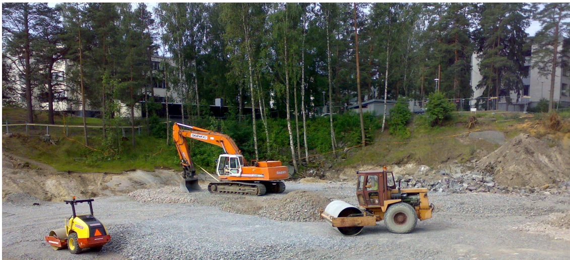
Kuva 2. Talon pohjan täyttö- ja tiivistystyöt käynnissä [9].
