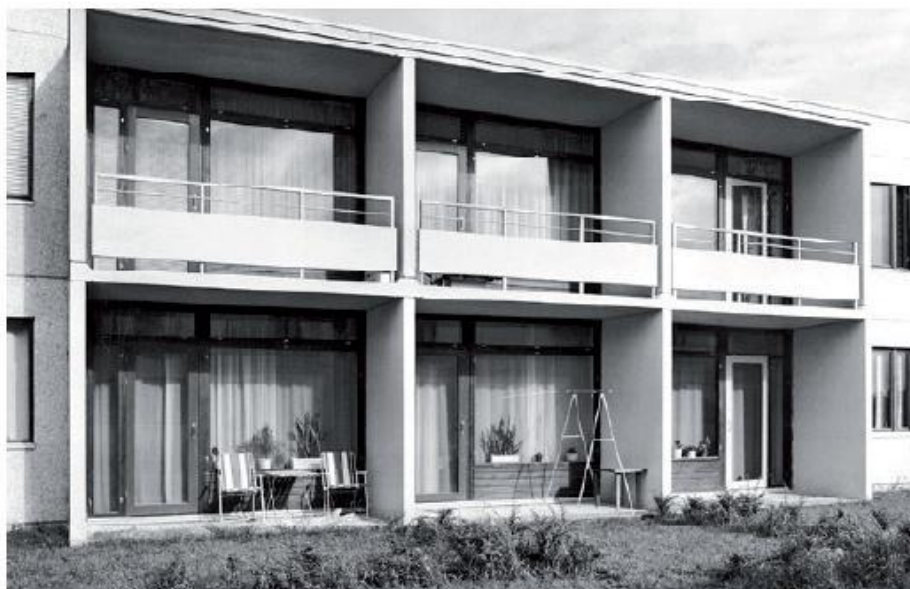
Kuva 6. Rakennusrungon ulkopuoliset parveketornit. (Junhonen & Karhu, 2012).
