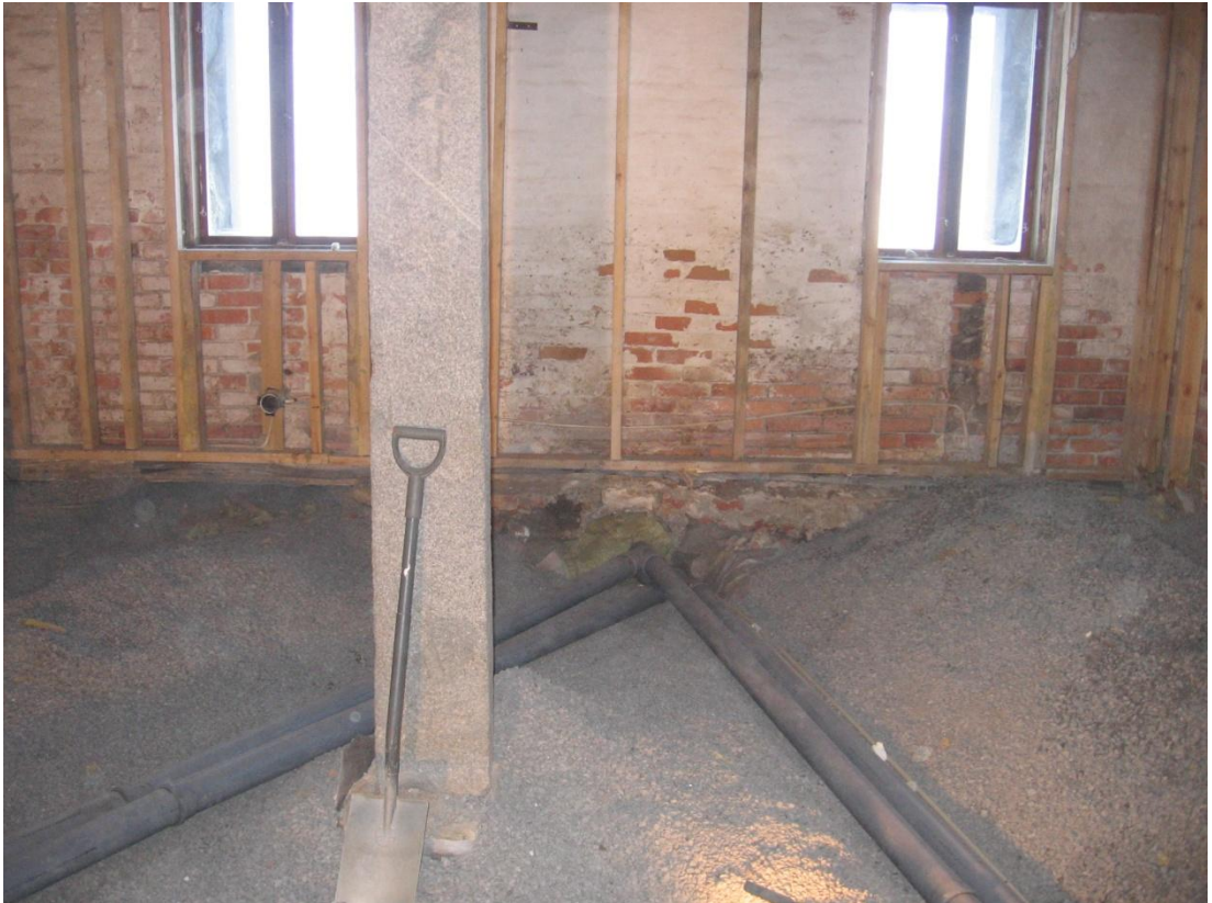
Kuvio 24. Ulkoseinässä yksi läpivientiaukko viemäriputkille (Paunila 2014)
