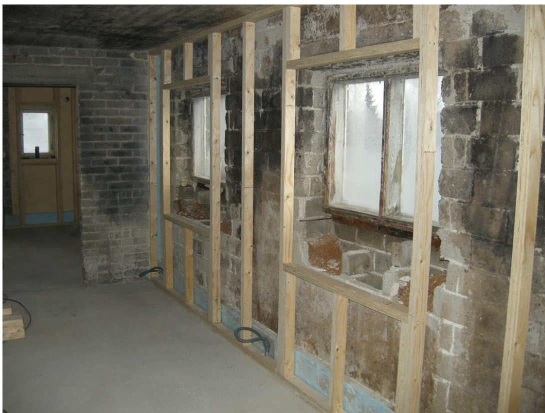
Kuvio 28. Uusi koolaus tiiliseinän kohdalla eristystä varten (Navetasta koti)
