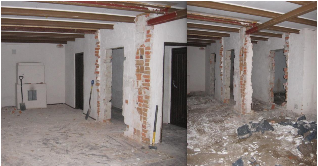
Kuvio 16. Käytävän oviaukon ja tiiliseinän purkamista (Paunila 2014)
