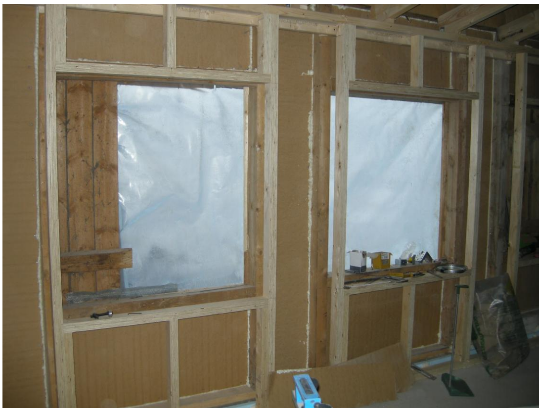
Kuvio 27. Uusi koolaus puuseinän kohdalla (Navetasta koti)
