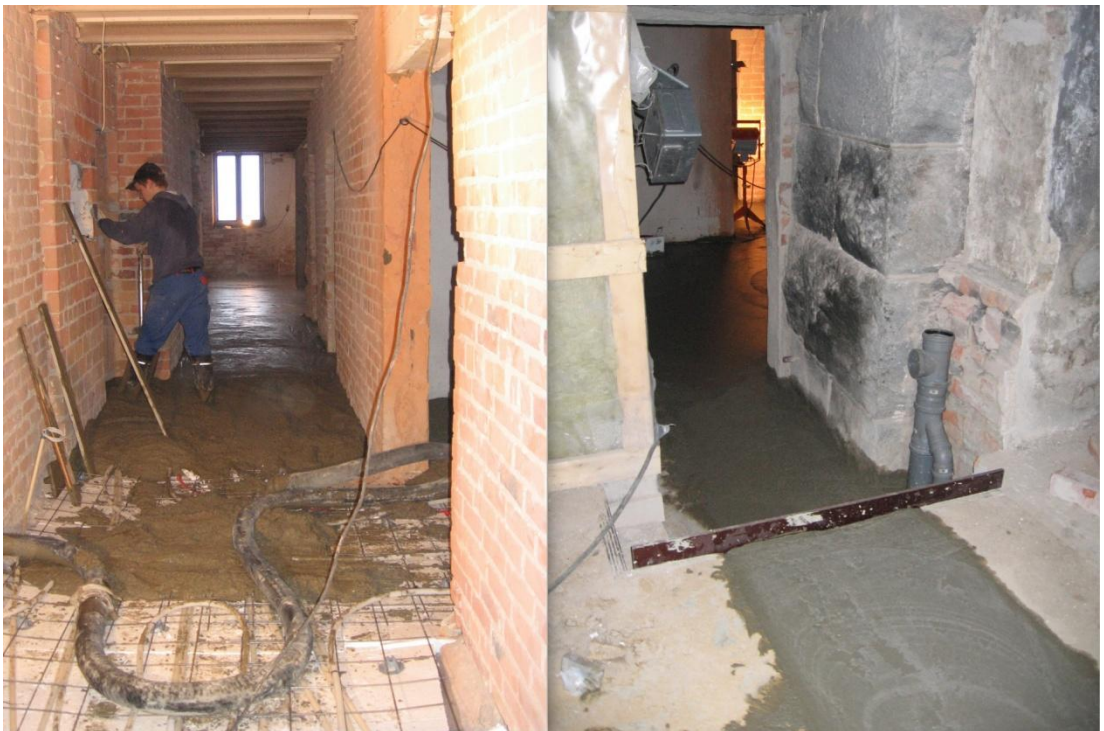
Kuvio 25. Lattialämmitysputket ja betonin valu (Paunila 2014)
