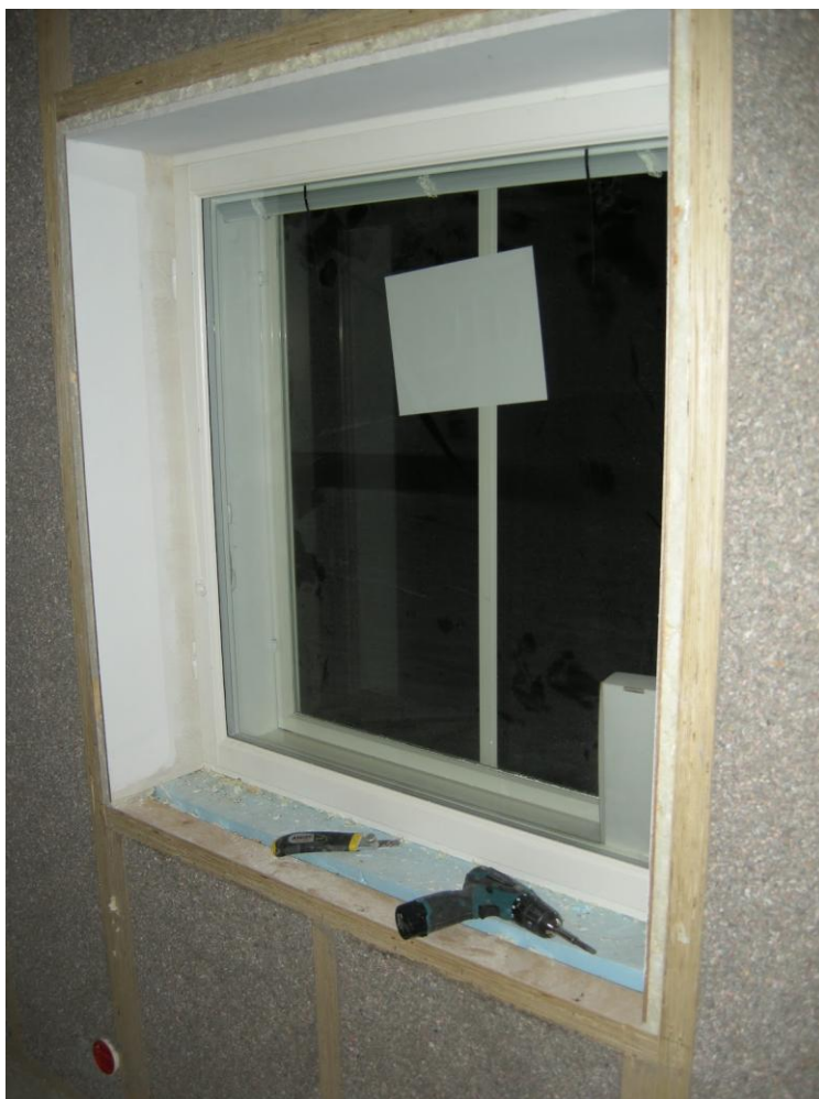
Kuvio 29. Osa ikkunoista on syvällä ja niissä on leveä ikkunapenkki (Navetasta koti)
