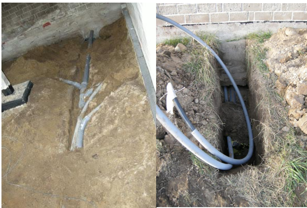
Kuvio 18. Viemärointiä ja ulkoseinän alitus (Navetasta koti)
