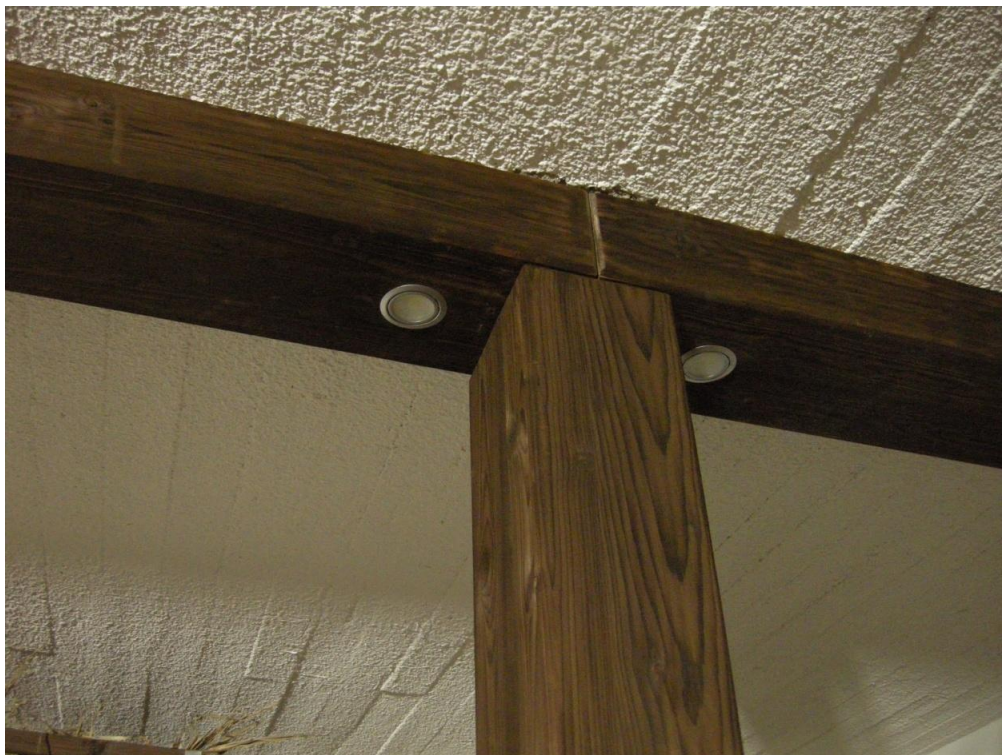
Kuvio 45. Puukotelo betonipylväille ja valaistus pylväille (Navetasta koti)
