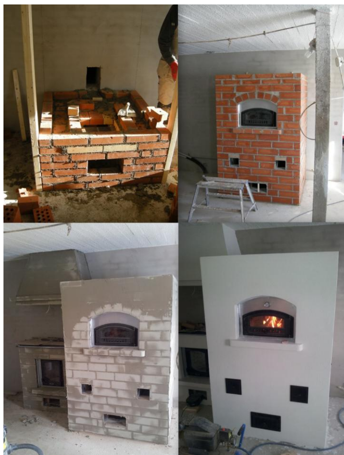
Kuvio 36. Takan muurausta, hierpinnottamista ja kuivattamista (Navetasta koti)
