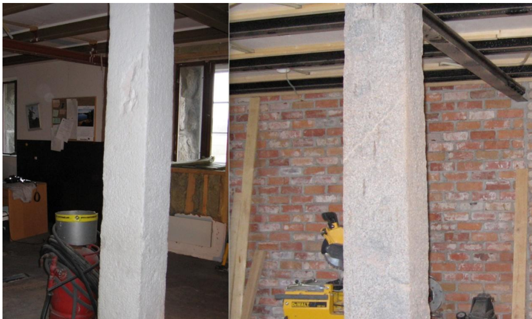
Kuvio 40. Graniittipylväs ennen ja jälkeen hiekkapuhalluksen (Paunila 2014)
