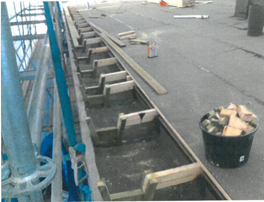
Kuva 12. Räystäskourun työ käynnissä. Valvojan valokuva
