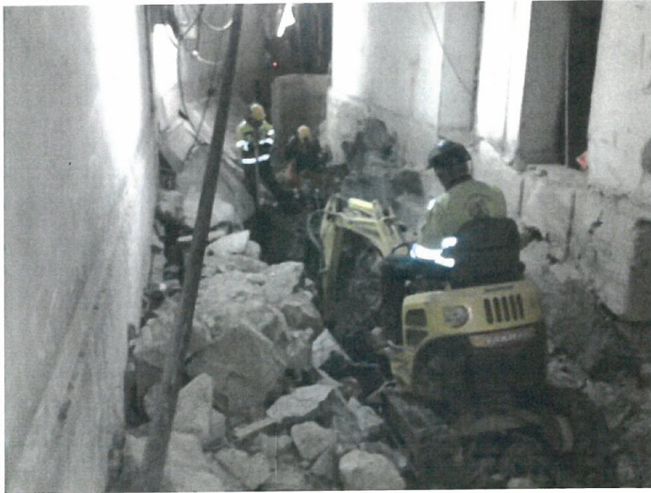
Kuva 7. Kellarin käytävän purkutyö käynnissä. Valvojan valokuva
