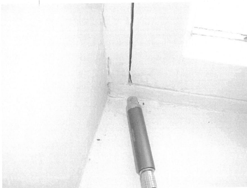
Kuva 4. Ikkunaliittymän tiiveystutkimus (3 s. 28).
