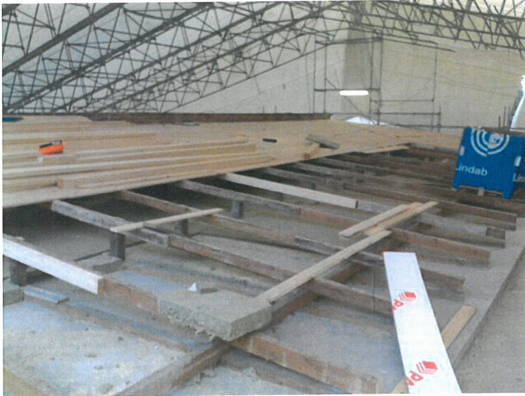
Kuva 11. Vesikattotyö käynnissä suojateltan alla. Valvojan valokuva
