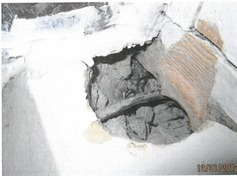
Kuva 3. Rakenneavaus ikkunan alapuolelta (12 s.10).
