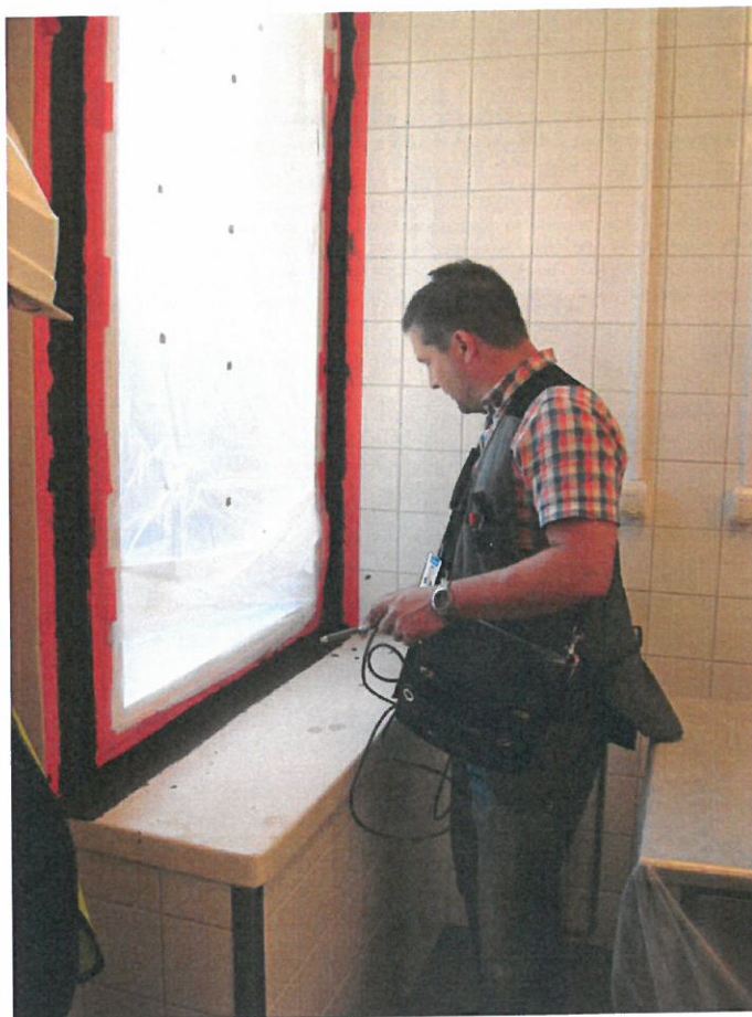
Kuva 9. Keittiön ikkunan tiivistystarkastus merkkiainekokeella. Valvojan valokuva.
