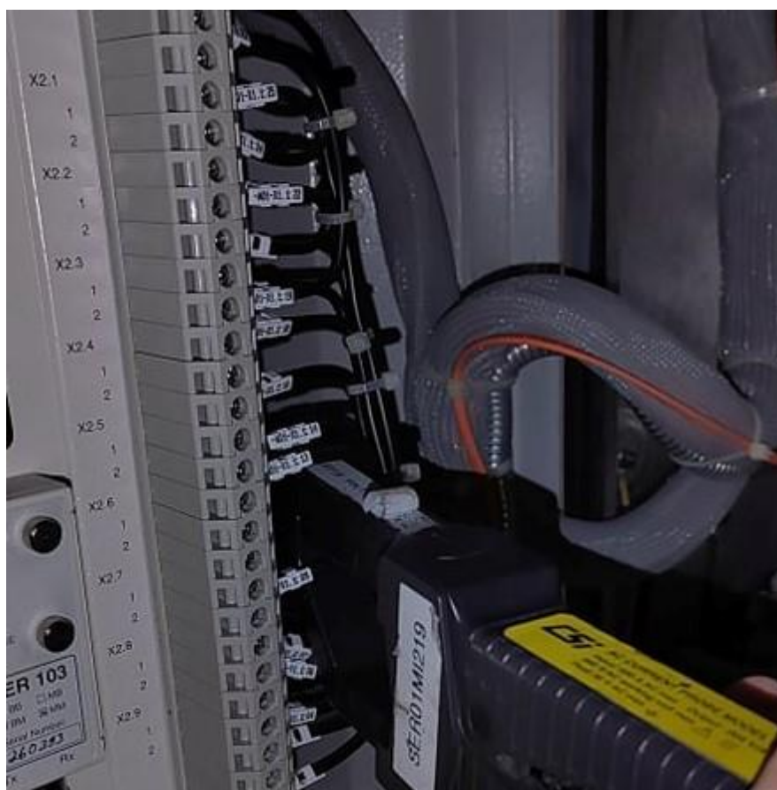
Kuva 24. Mittaus virtamuuntajan toisiopiiristä Pietarsaaren paperi- tehtaalla
