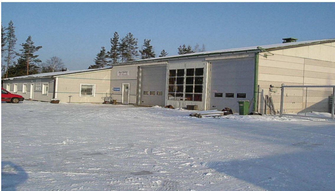
Kuva 1. Toimisto- ja hallirakennus
