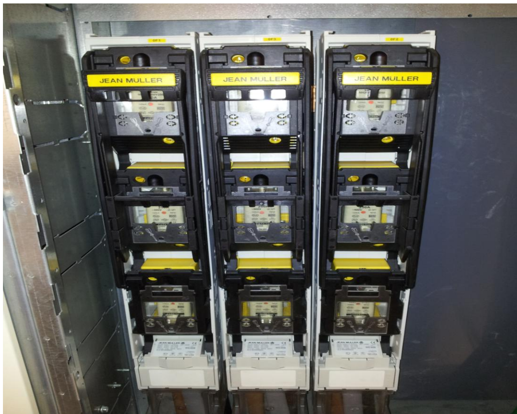
Kuva 12. Pääkeskuksen pääsulakkeet
