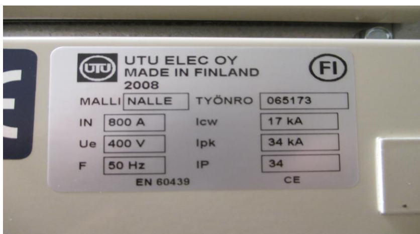
KUVA 6. Pääkeskuksen arvokilpi
