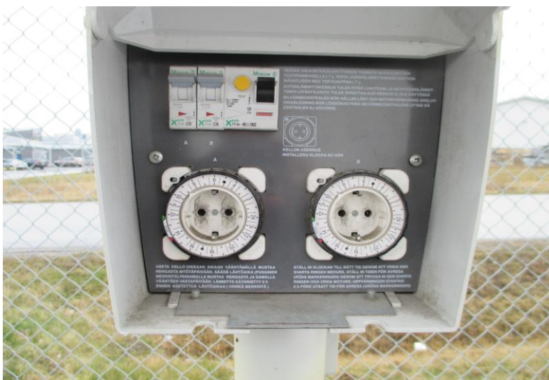
Kuva 10. Autolämmityspistorasiatolppa
