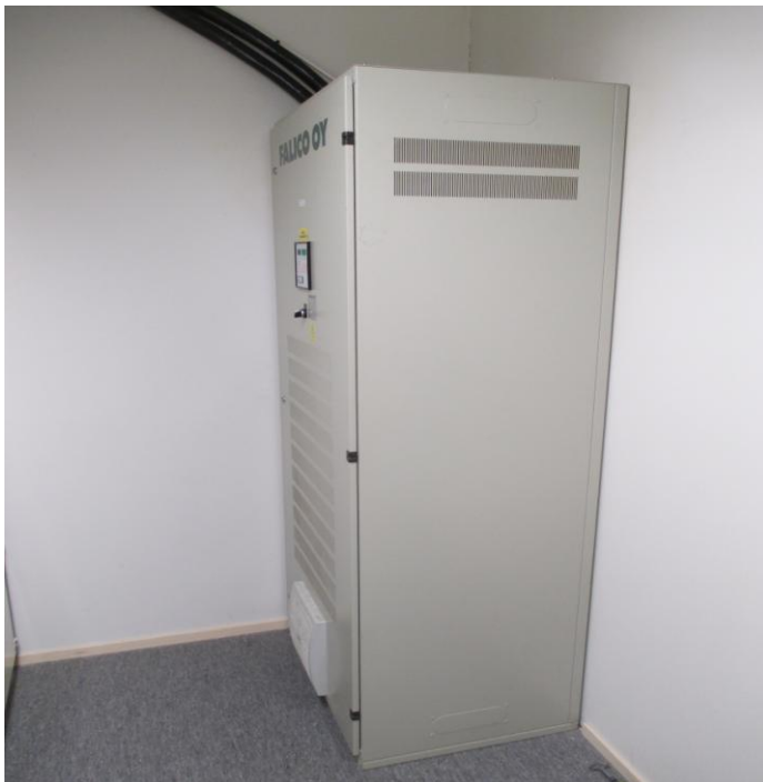
KUVA 5. Falicon 300 kVAr kompensointikeskus
