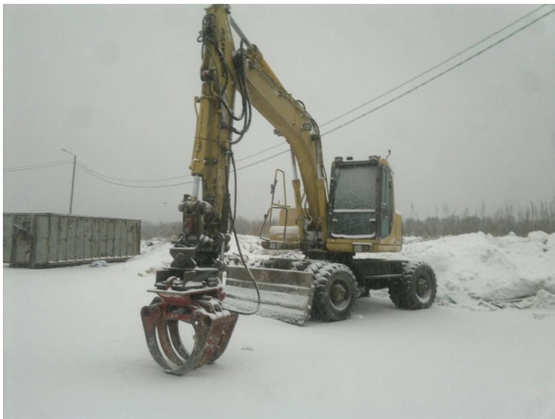
KUVA 16. Kouralla varustettu kaivinkone jätteiden siirtelyyn. Kuva: Lauri Kervola
