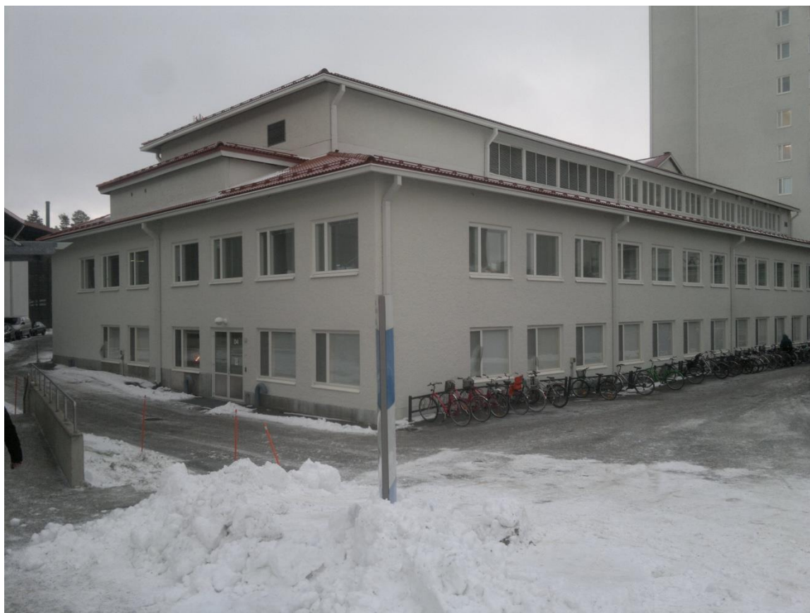
KUVA 13. Keskussairaalan työmaa. Kuva: Lauri Kervola 2013
