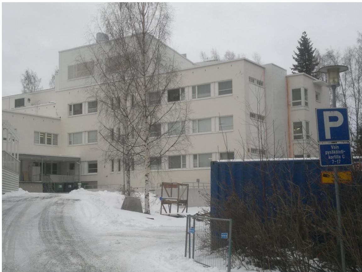
KUVA 11. Tikkarinteen työmaa. Kuva: Lauri Kervola 2013
