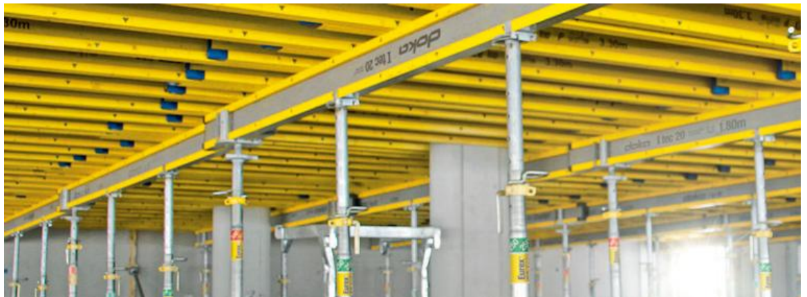
Kuva 5. Valmis holvimuotti alapuolelta kuvattuna (Doka.com)
