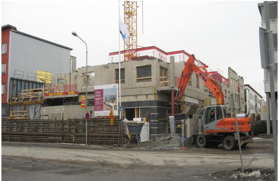
Kuva 9. Satamanpihan rakennustyömaa (Ryhänen 2014)
