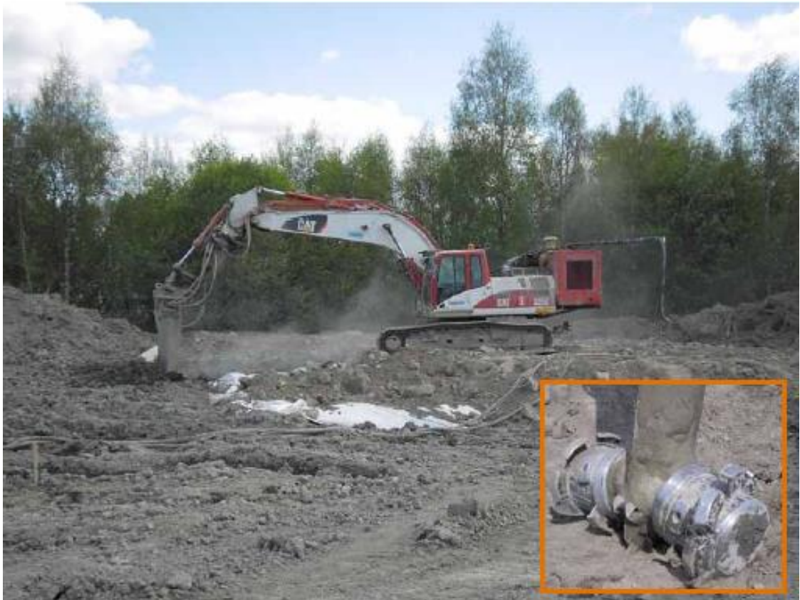
KUVA 7. Massastabilointilaitteisto (kuva Vt8 Sepänkylän ohikulku -hankkeelta)
