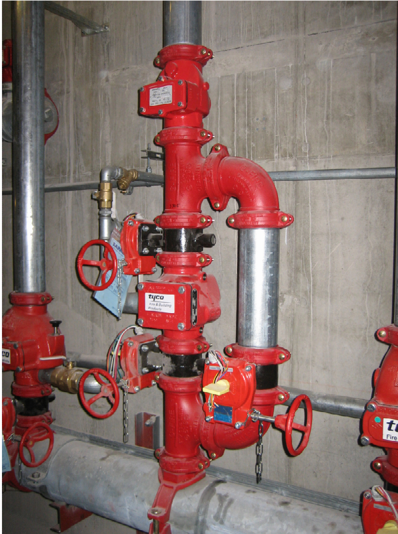
Kuva 10. Asennusventtiili.
