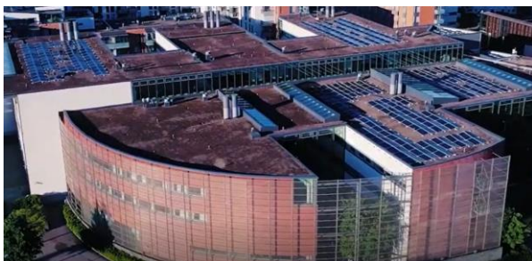
Kuvio 3. Ammattikorkeakoulun katolle asennettu aurinkosähköratkaisu, jonka toiminnallisuuksia hyödynnetään niin opetuksessa kuin kiinteistön energianhallinnassa. (Yritys x 2021.)
