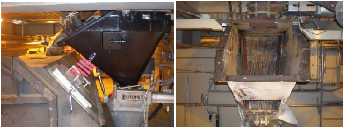
KUVAT 15–16. Uusittu pudotuslaitteisto
