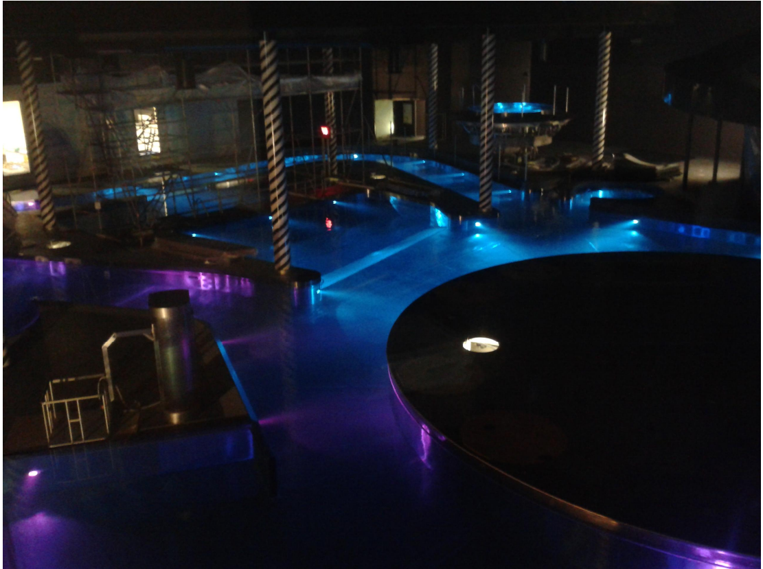
Kuvio 5. Allasosasto rakentamisen viimeistelyvaiheessa
