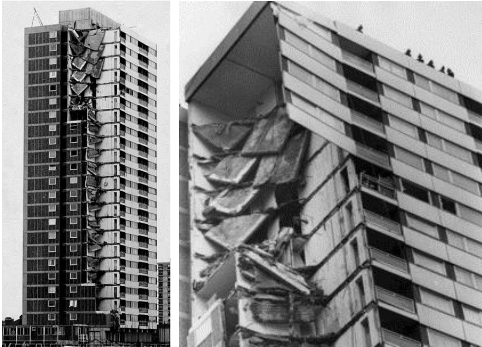
Kuva 8. Ronan Pointin asuinrakennus onnettomuuden jälkeen [25]
