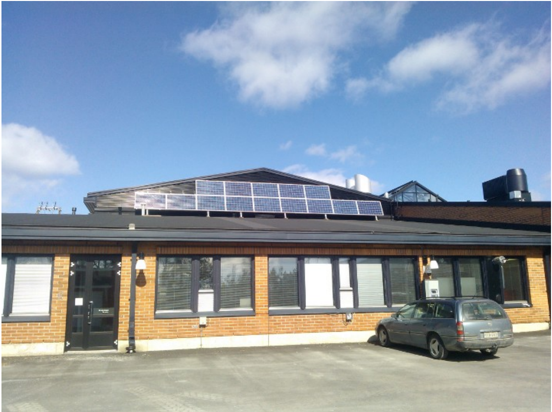
Kuva 3. Aurinkopaneelit katolle asennettuna
