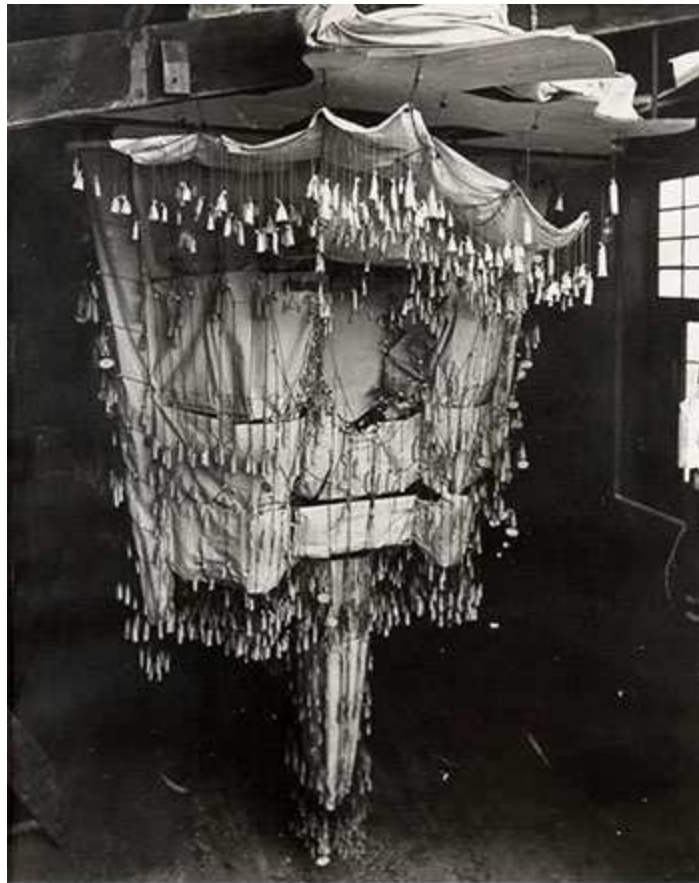
Gaudin ylösalaisin riippuva kappelin parametrinen malli. ( http://www.gaudicoloniaguell.org/en/gaudi-lab/his-method )
