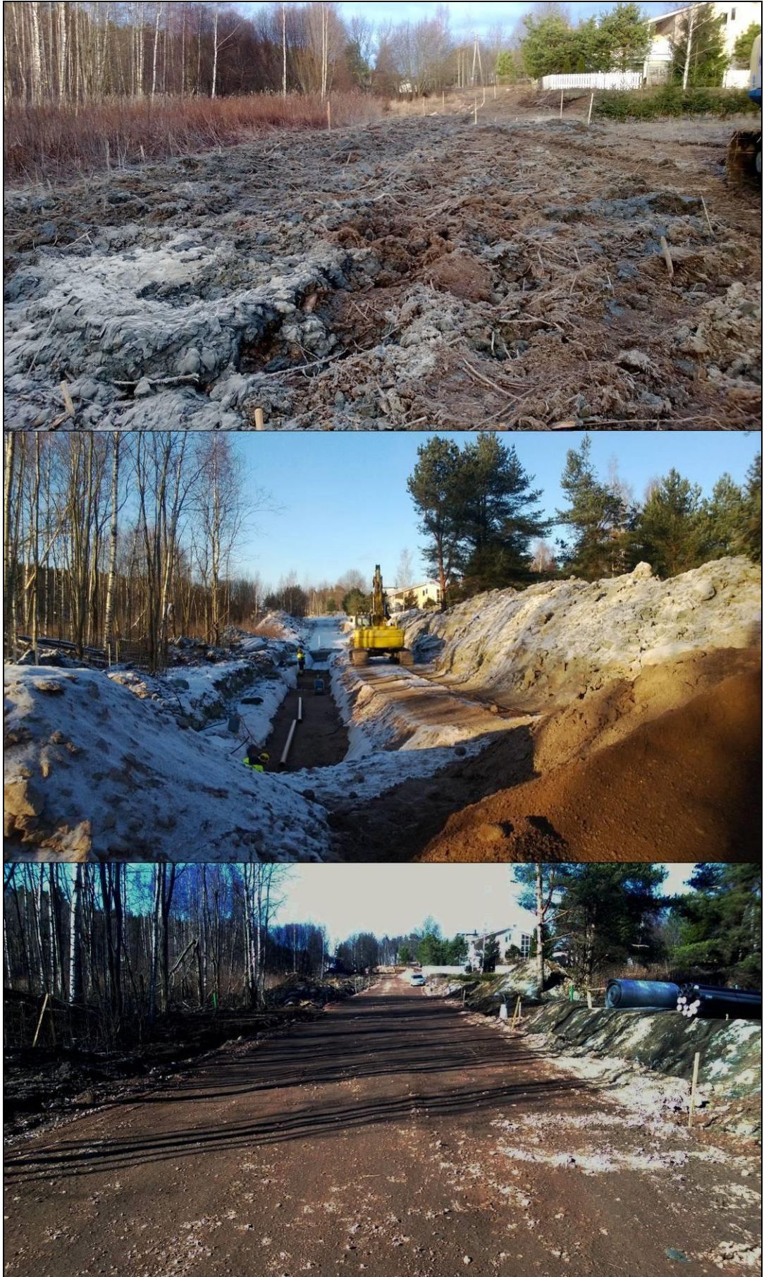
Kuva 28. Pilaristabiloitu maa, vesihuoltolinjan rakennus ja Ahonlaidan tien rakentaminen Ahonpellonkadulta katsottuna. (Kuvat: Otto Rekula 2014.)
