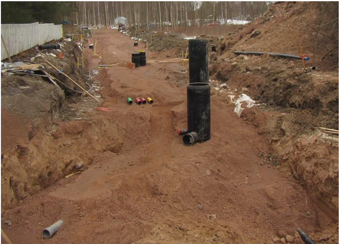
Kuva 31. Putkikaivantoon asennetut putket. (Kuva: Otto Rekula 2014.)
