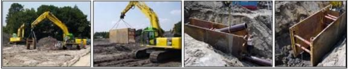
Kuva 8. Kaivantoelementin asennus kaivantoon (KT-Tuenta Oy 2007.)
