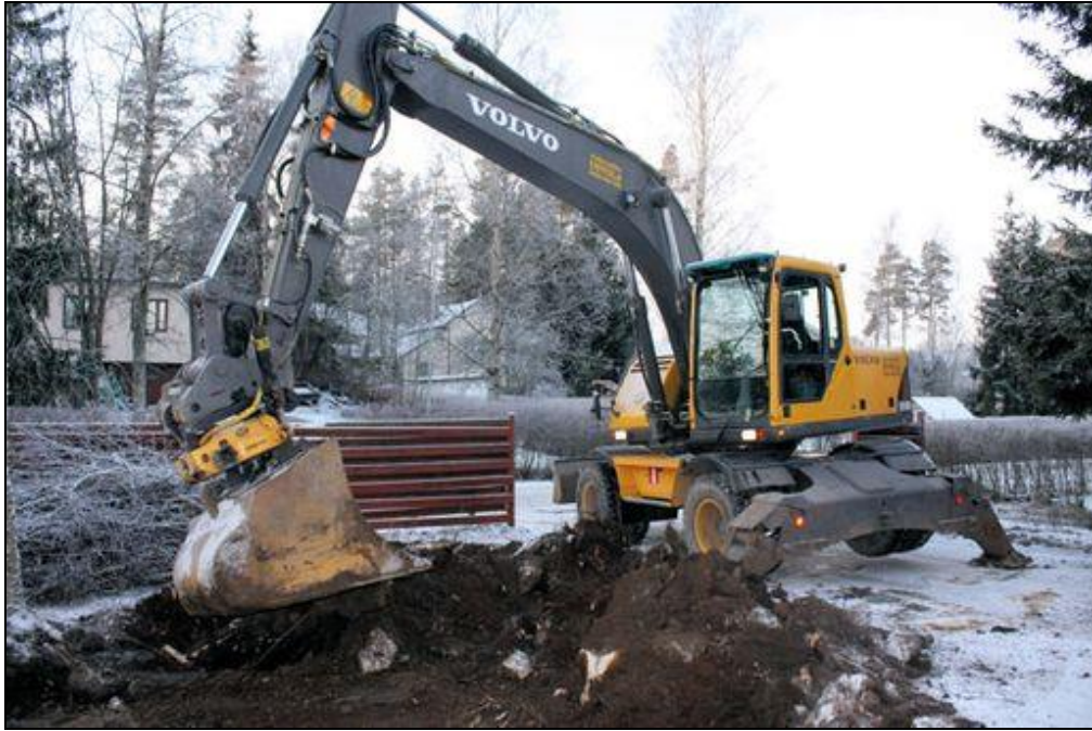
Kuva 20. Pyöräalustainen kaivinkone, KKHp (Kuljetusliike Usvola 2014.)
