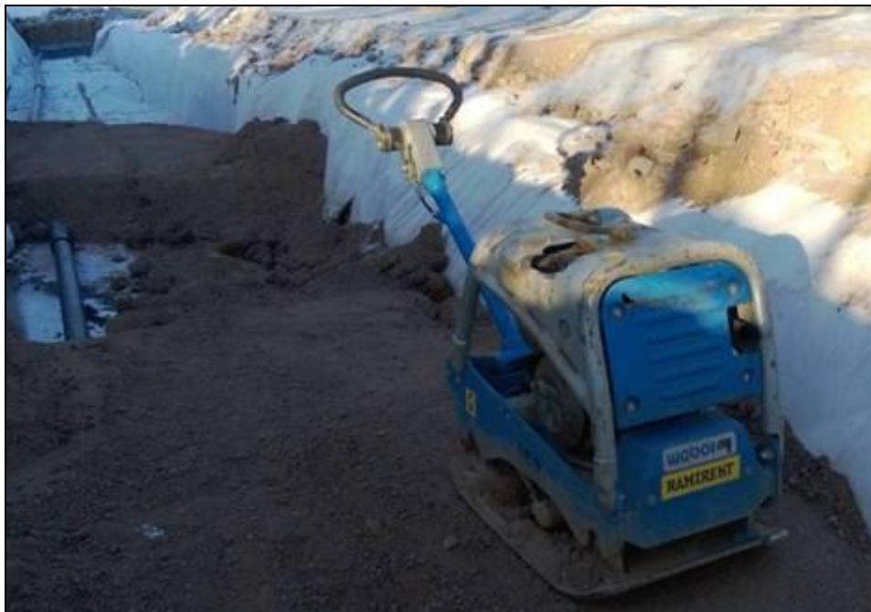
Kuva 18. Tyypillinen putkikaivannon rakennekerrosten tiivistyksessä käytettävä tärylevy. Kuvassa alkutäytön tiivistämistä. (Kuva: Otto Rekula 2014.)
