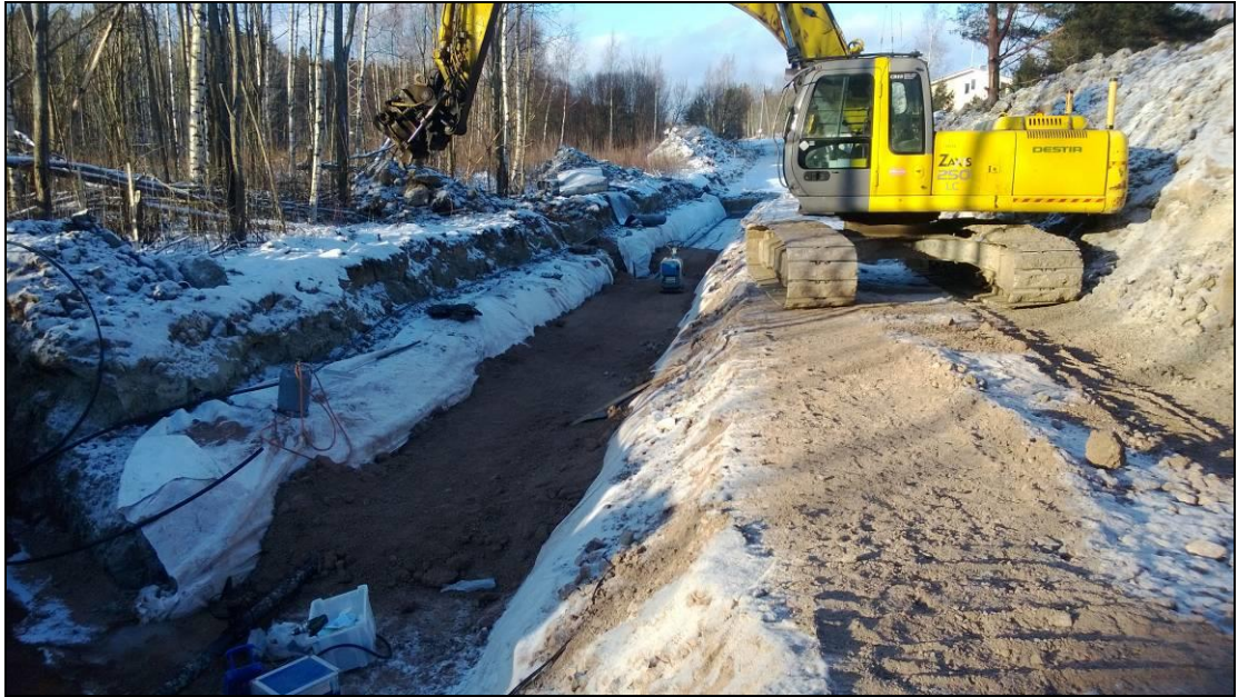
Kuva 30. Ahonlaidan putkikaivanto. Oikealla rakennettu työmaatie. (Kuva: Otto Rekula 2014.)
