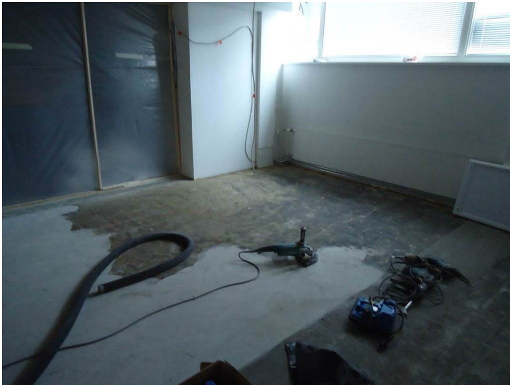
Kuva 14. Bitumiliiman hionta kesken hiomakoneella, jossa on kohdepoistoliitântä. Kuvasta huomaa myös osaston olevan hyvässä alipaineessa muovisesta suojaseinästä, joka on klommollaan osastoon päin.
