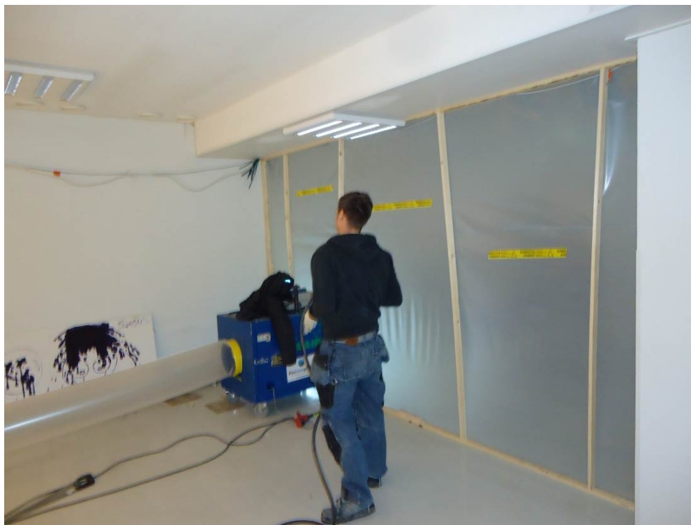
Kuva 24. Rimat ovat sijoitettu puhtaalle puolelle, jolloin niitä ei tarvitse hävittää, vaan ne voidaan käyttää uudelleen
