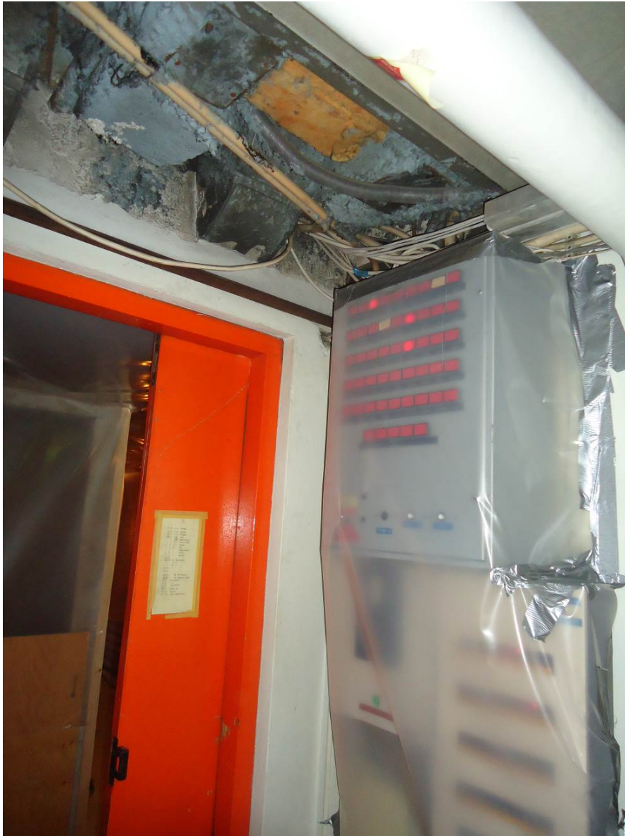
Kuva 23. Käytössä olevat sähkölaitteet suojattiin muovilla, jotta niiden taakse eikä sisälle pääse asbestipitoista pölyä purkamisen yhteydessä
