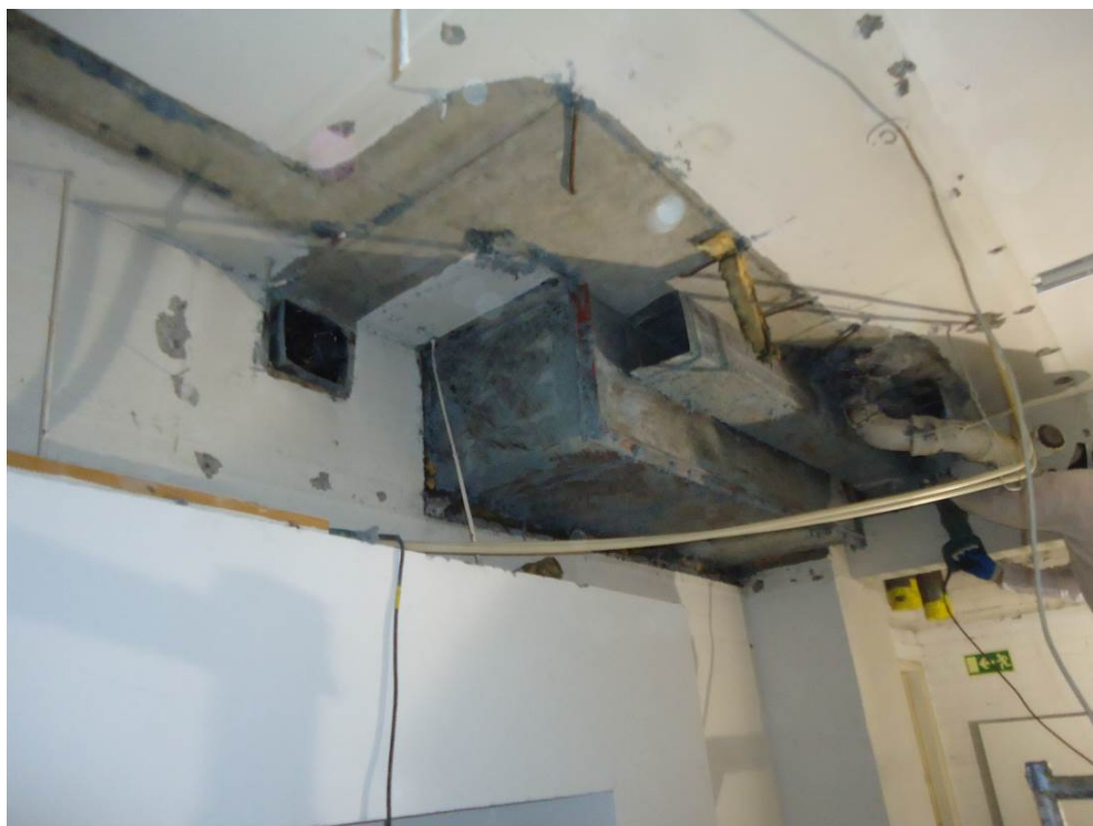
Kuva 27. Kanavista on irrotettu suurimmat krokidoliitit ennen niiden sahausta. Kanavan sahauksen jälkeen ilmastointikanava tukitaan, jottei pöly pääse leviämään kana-vaan.
