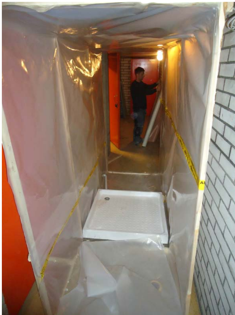
Kuva 18. Kolmiosaisen sulkutunnelin muovisaumat teipataan tiivisti toisiinsa kiinni. Keskimmäiseen osaan rakennetaan pesutilat.
