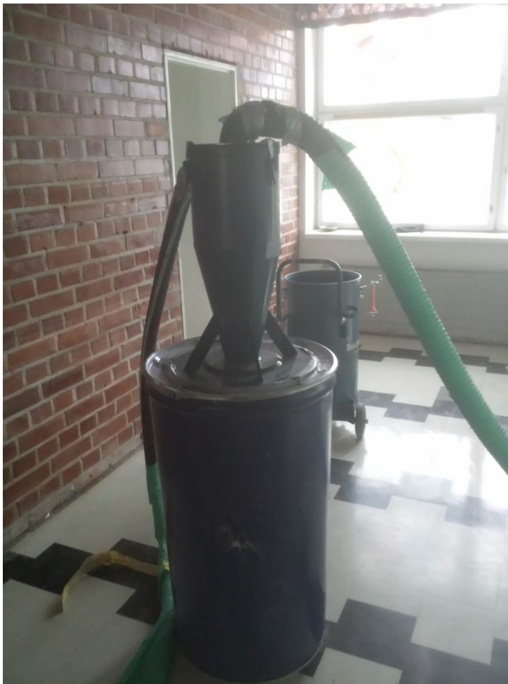
Kuva 13. Finnflex-vinyylasbestilaattoja koulurakennuksen käytävällä sekä imurin esierottelija
