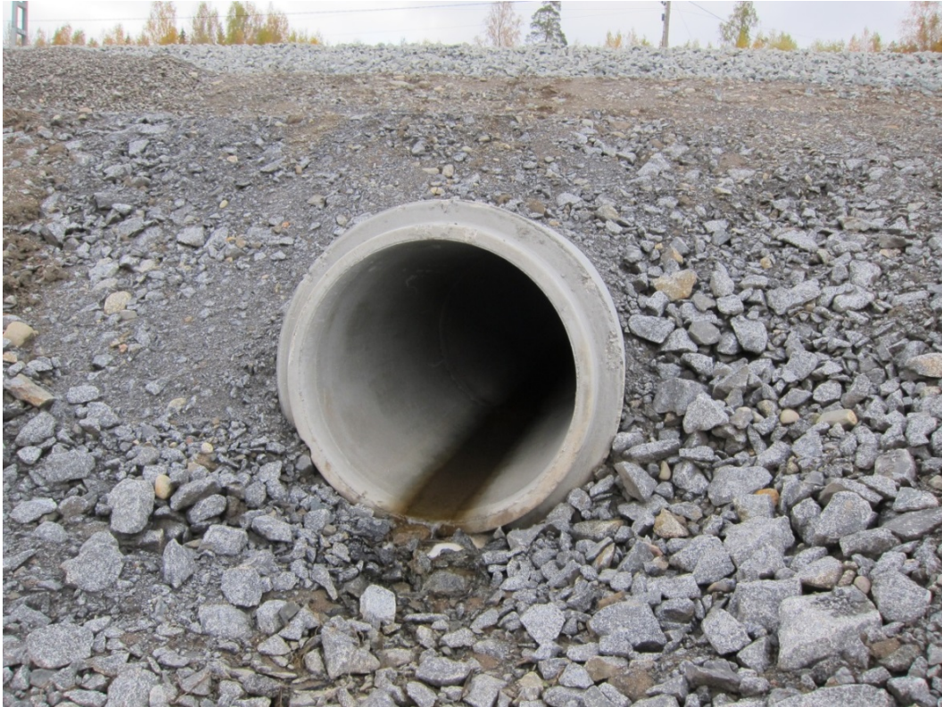
KUVA 5. Pyöreä betoniputkirumpu asennettuna (Kuva: Tuomo Passi 2012)
