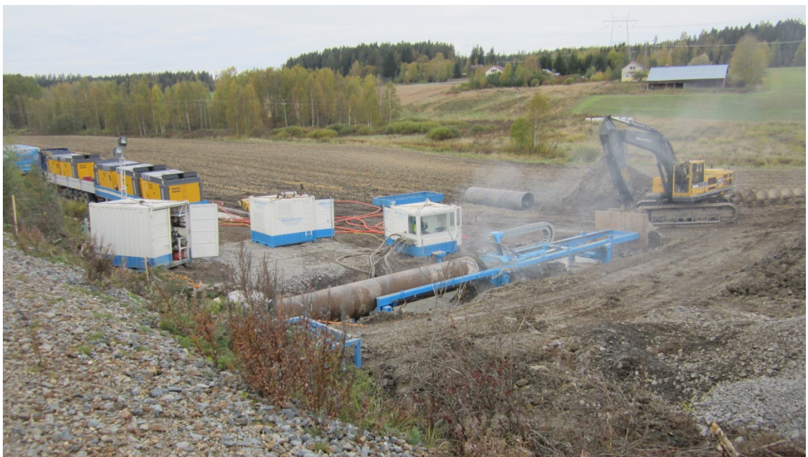
KUVA 15. Teräsputken asennus poraamalla (Kuva: Tuomo Passi 2013)
