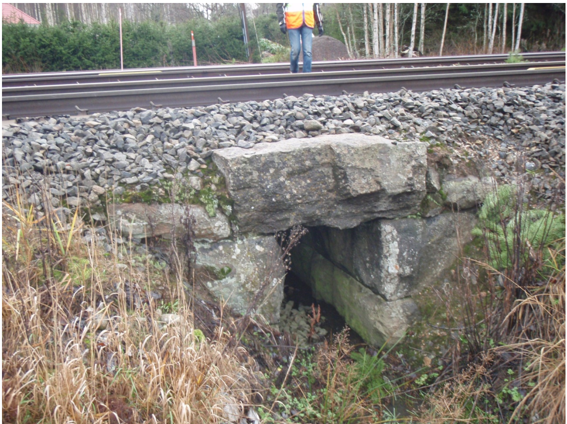
KUVA 3. Holvirakenteinen kivirumpu toiminnassa (Kuva: Tuomo Passi 2011)
