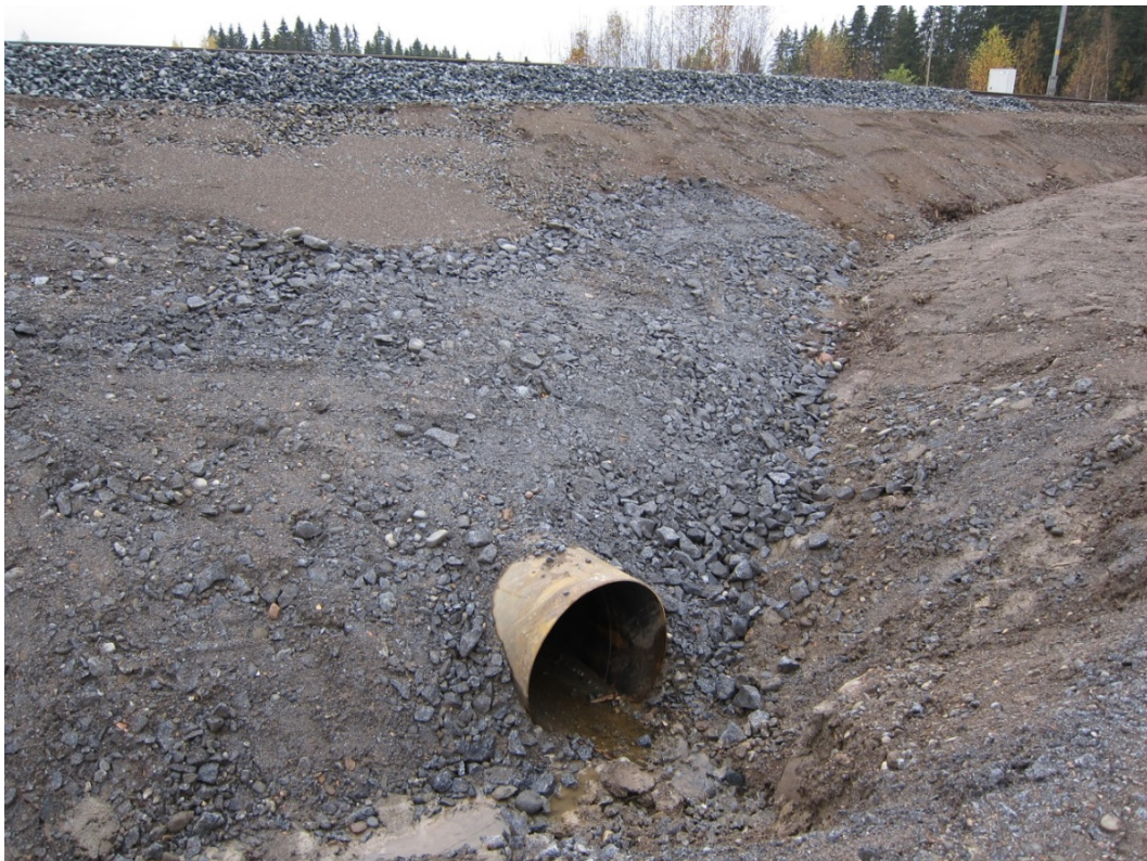
KUVA 6. Teräspuokirumpu pengeri aukikaivaen asennettuna (Kuva: Tuomo Passi 2012)
