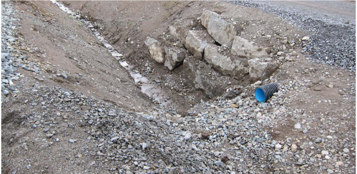
KUVA 10. Muovinen huoltotierumpu asennettuna (Kuva: Tuomo Passi 2012)
