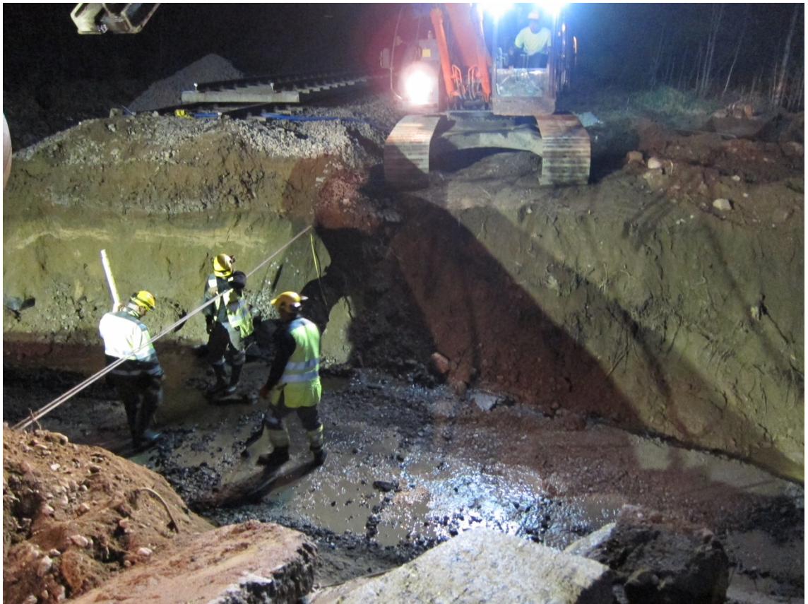
KUVA 11. Rautatiepenger aukikaivettuna (Kuva: Arttu Tuominen 2013)
