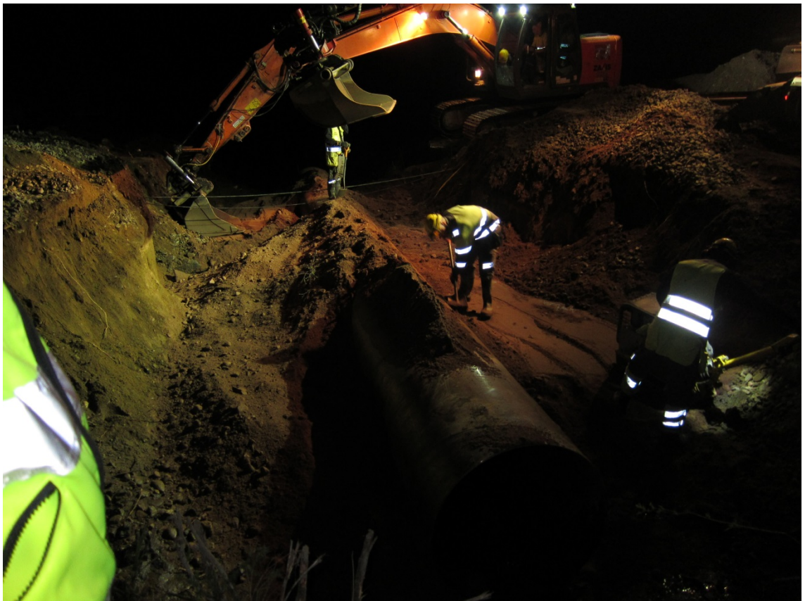
KUVA 12. Teräsputki asennettuna paikoilleen (Kuva: Arttu Tuominen 2013)
