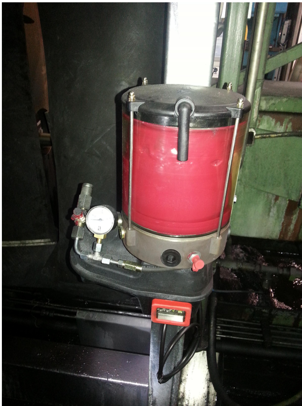
Kuva 32. Pituussaumahöylille ja hitsauspukille asennettu automaattinen rasvapumppu
