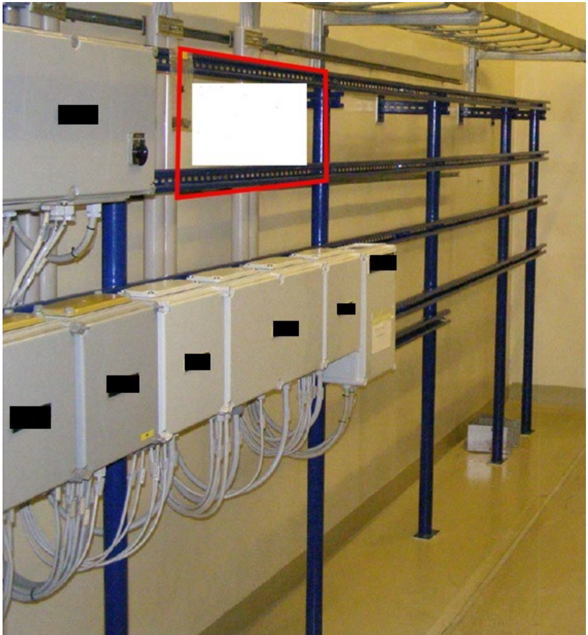
Kuva 6. Uuden kotelon asennukseen käytettävä, olemassa oleva teline
