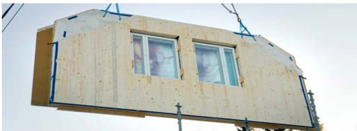
Kuvio 3. Asennusvalmis CLT-elementti (Stora Enso Oy 2012)
