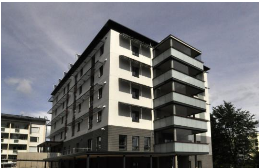
Kuva 10. As Oy Jampankaari. Kiinteät vaakasäleiköt varjostimina kerrosten välissä. Rakennuksen päädyssä varjostimina aurinkopaneelit. (Nollaenergia [viitattu 18.3.2014].)
