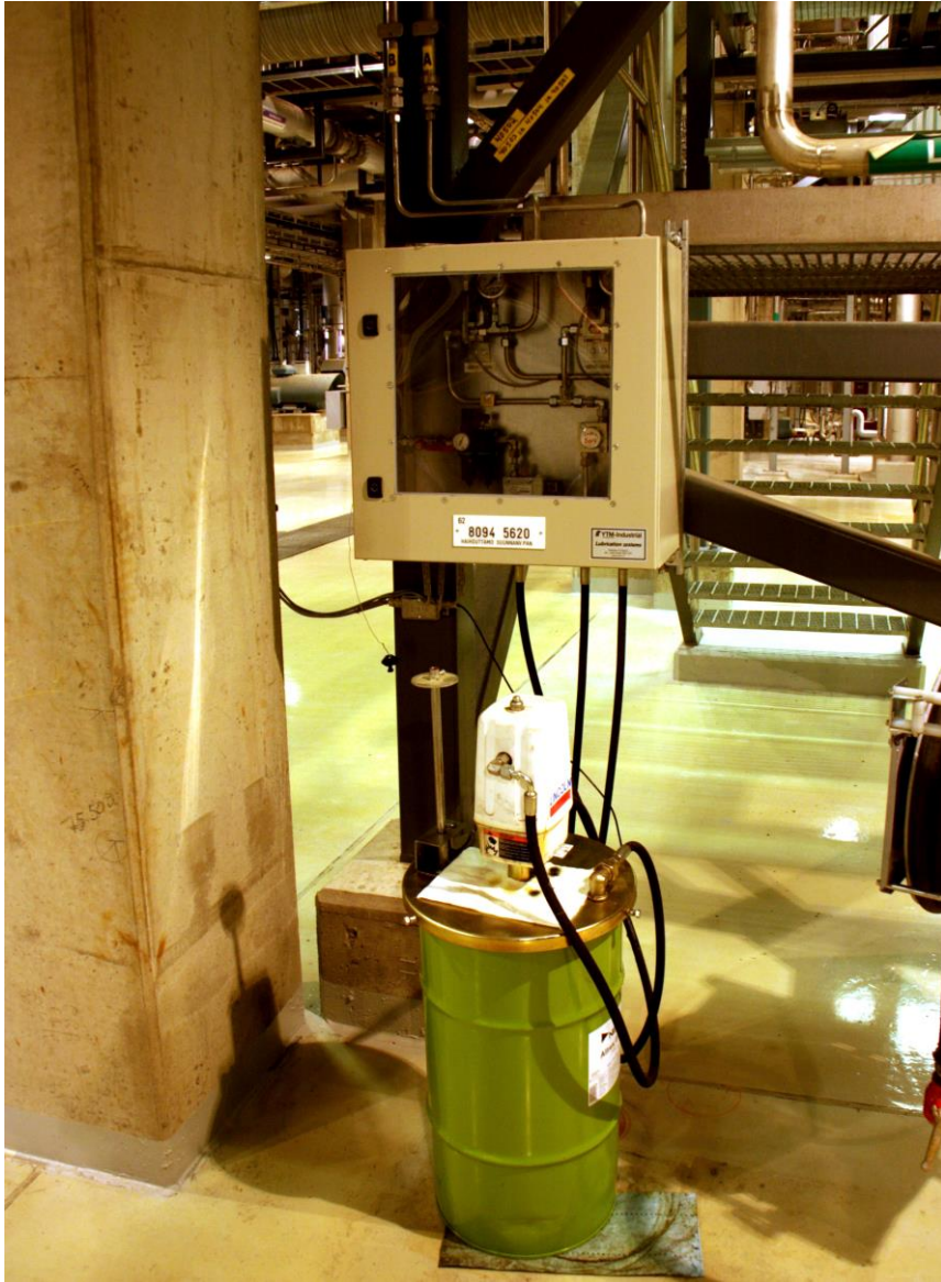
Kuva 12. Haihduuttamon kaksilinjaisenjärjestelmän pumppausyksikkö ja suunnanvaihtopaneeli (kuva: Niko Spets)
