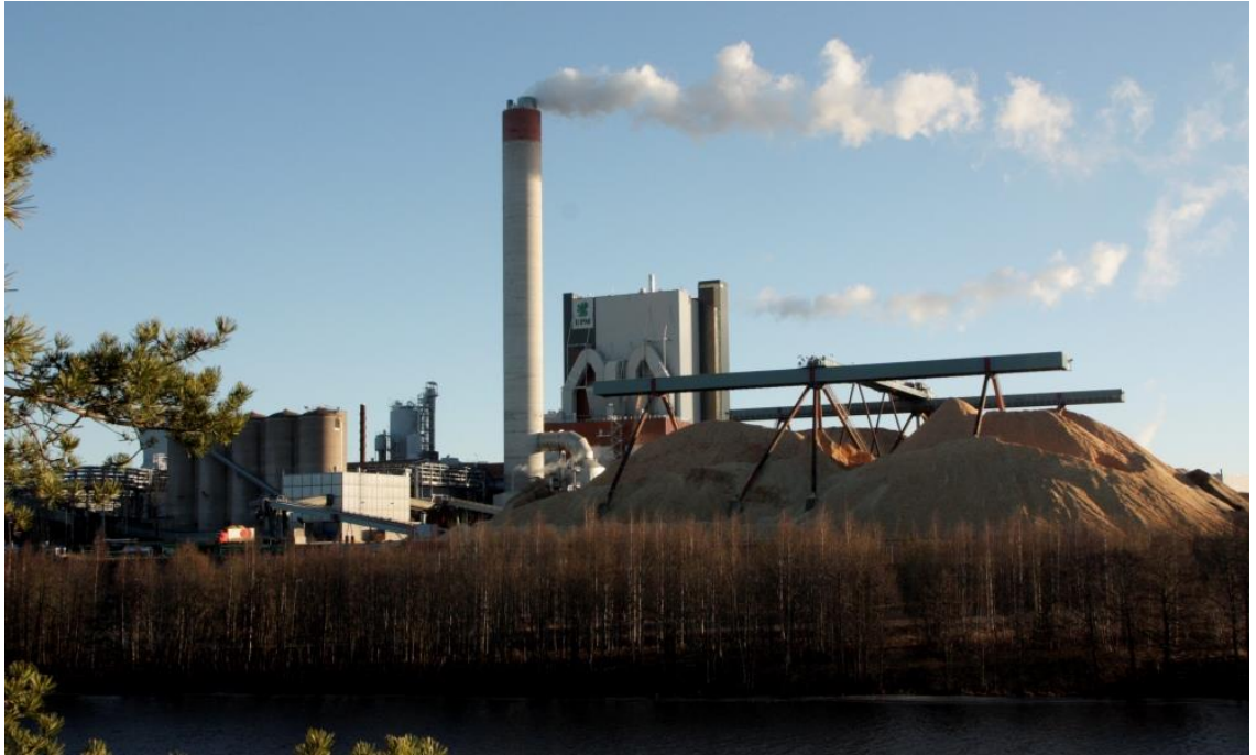
Kuva 3. Kymin talteenottolaitos maaliskuussa 2014 (kuva: Niko Spets)
