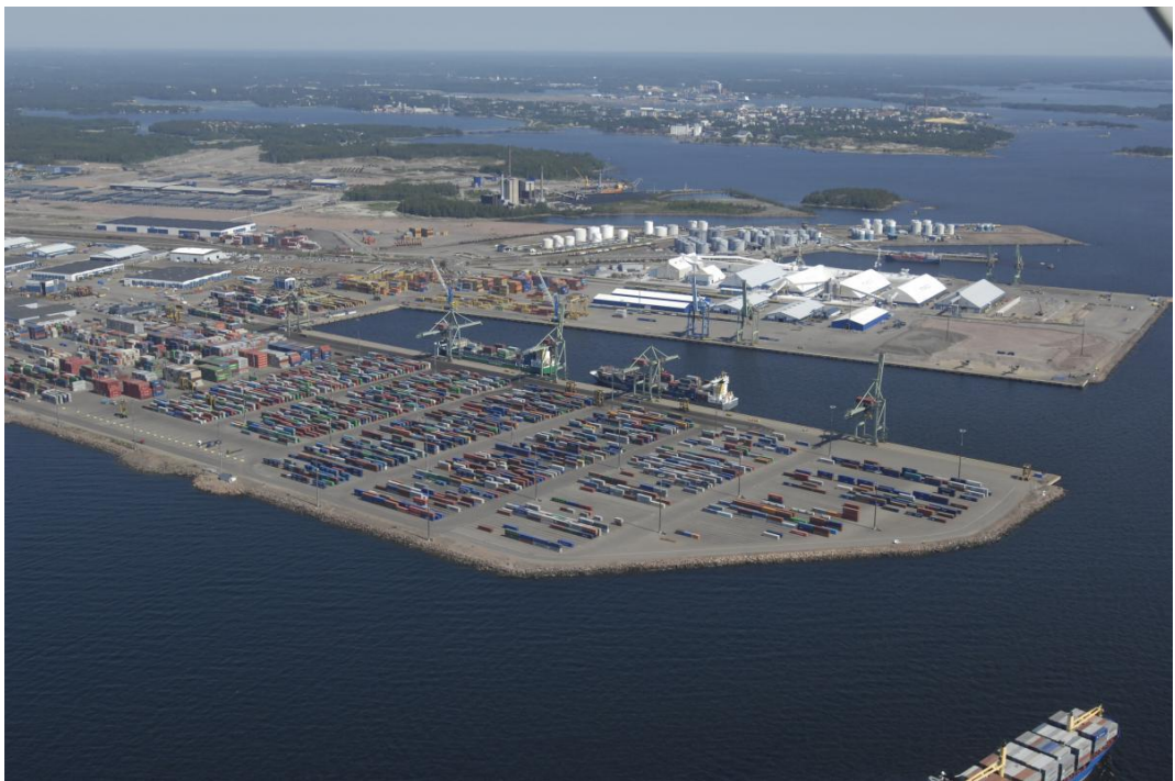
Kuva 3. Mussalon satama (HaminaKotka Satama Oy 2014)
