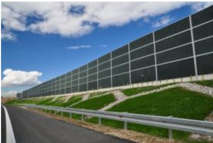
Kuva 6. Meluvallin ja meluseinän yhdistelmä. (Weldon 2014.)
