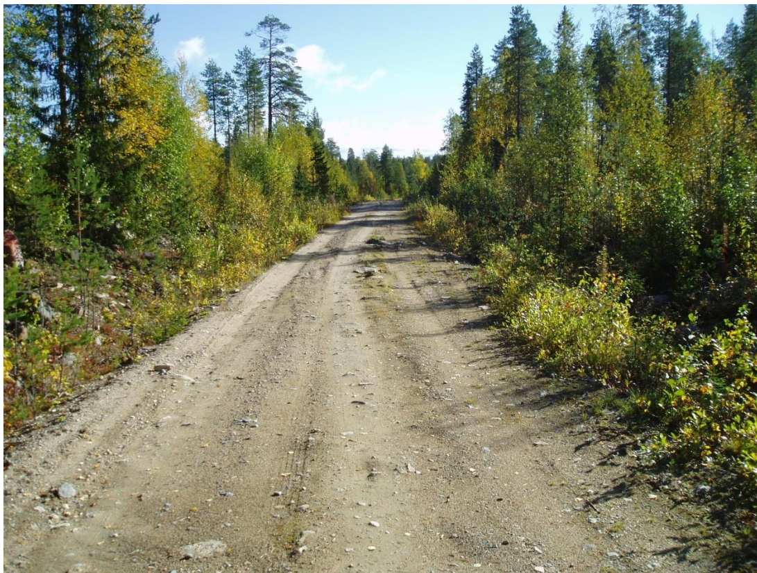
Kuvio 4. Perusparannuksen tarpeessa oleva metsätie (Hökkä 2013)
