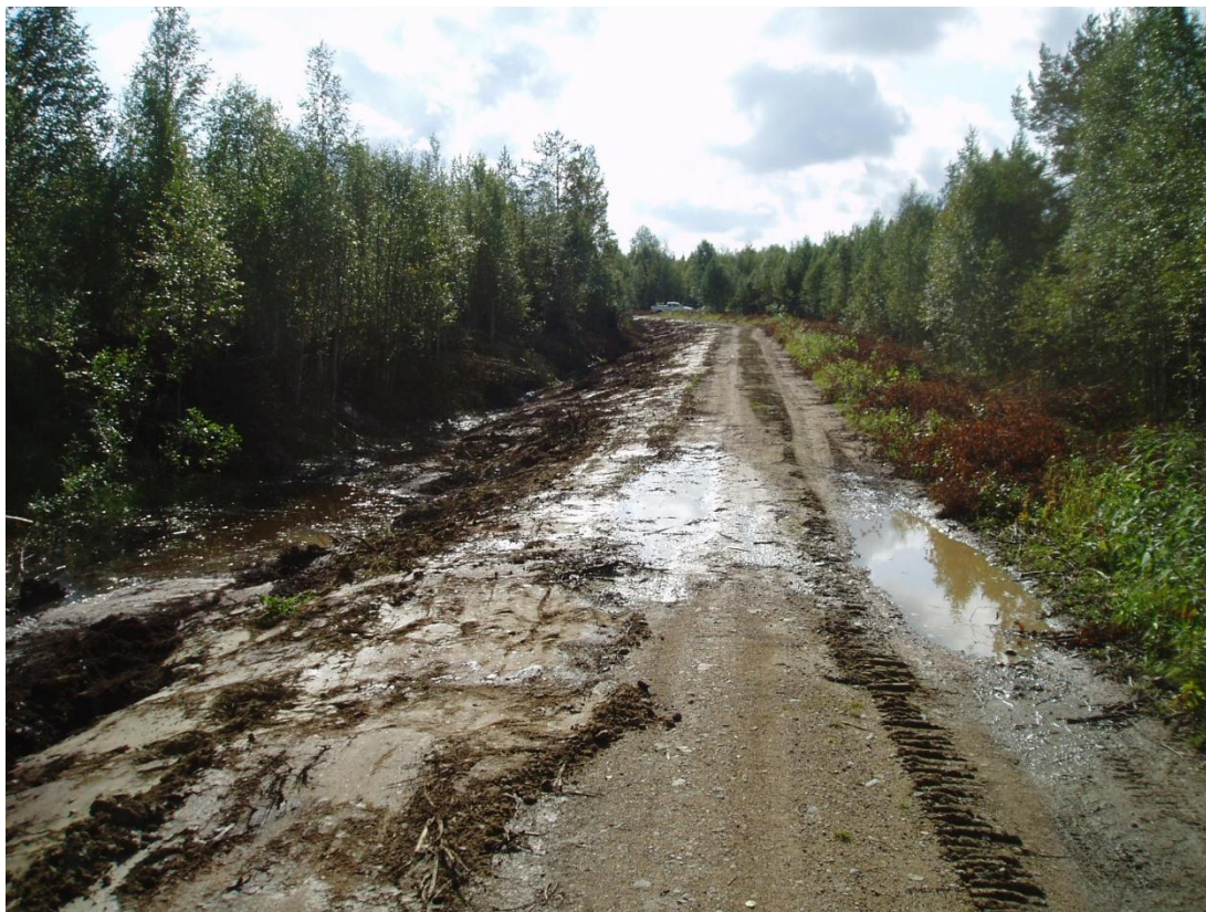
Kuvio 5. Tien puutteellisen kuivatuksen korjaustoimenpiteitä (Hökkä 2013)
