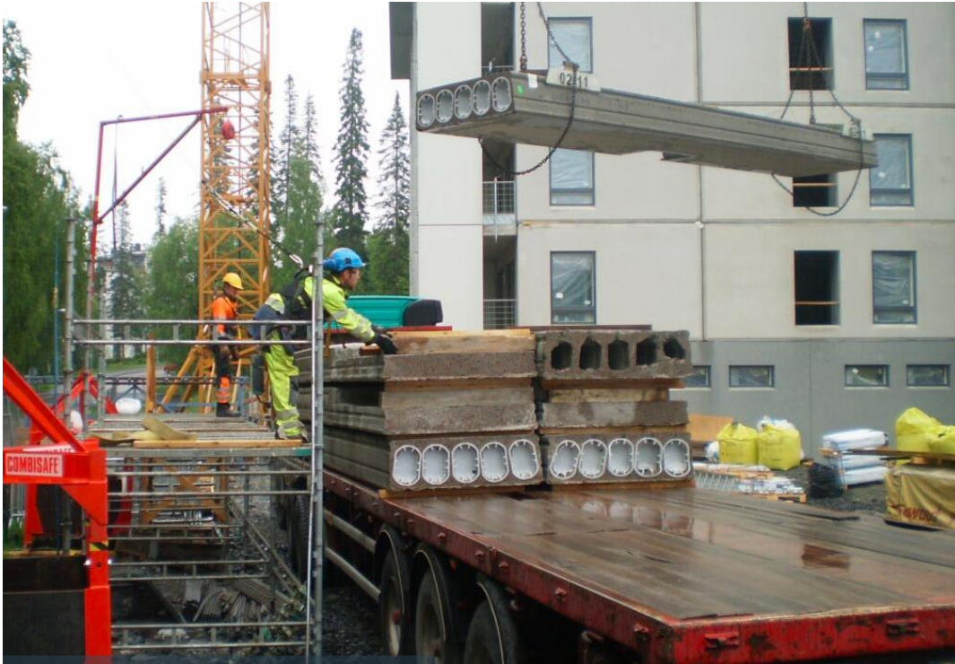
KUVA 2. Esimerkki telineestä, jossa tarvitaan valjaat sillä kuorman päältä putoamista yli kahdesta metristä ei ole estetty ajoneuvon kummaltakin puolelta (Mannila 2014)
