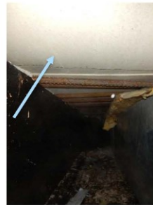
Kuva 2. Kuva betonipalkkien välisestä ilmatilasta. Kuitusementtilevy palkkien päällä
