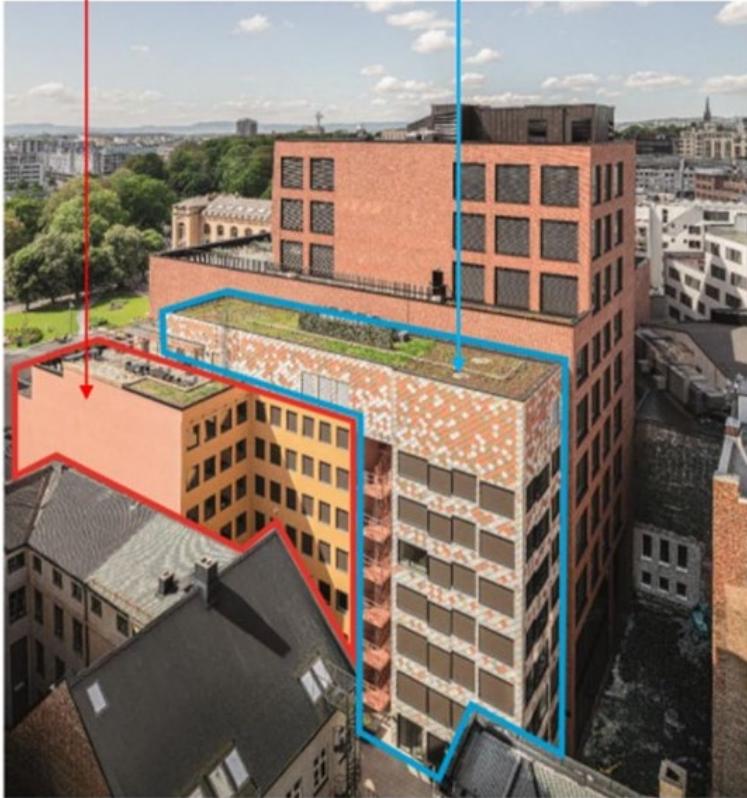
Kuva 5. Oslon kohteen yleiskuva. Alkuperäinen kuva: Kyrre Sundal/Mad Arkitekter.
