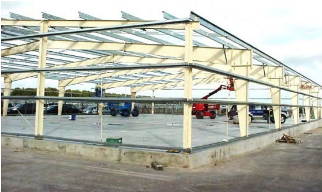
Kuva 8. Vanhan teräsrakenteen uudelleenkäyttö Hondan varastorakennuksen rakentamisessa. Kuva: Caunto Engineering Limited (Cullen & Drewniok 2016).
