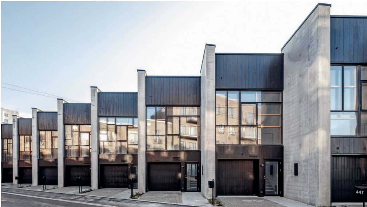
Kuva 4. Kohteen julkisivuissa on hyödynnetty kierrätysmateriaaleja. Kuva: Rasmus Hjortsjøj, COAST (Koivisto 2020).
