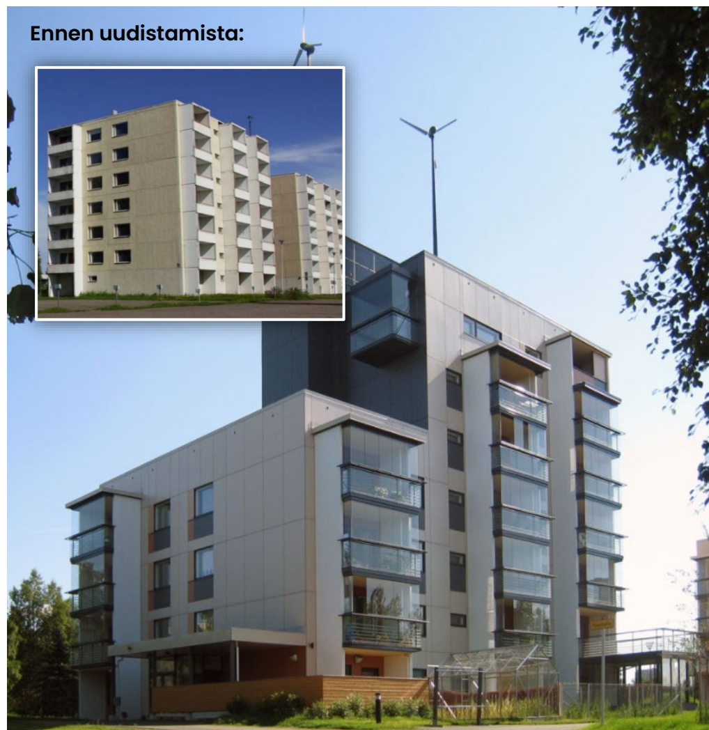
Kuva 2. Kiinteistö Oy Kummatti ennen uudistamista ja uudistamisen jälkeen. Kuvat: Arkkitehtitoimisto Harri Hagan (Huuha 2016) ja Arkkitehdit Kontukoski Oy 2021.
