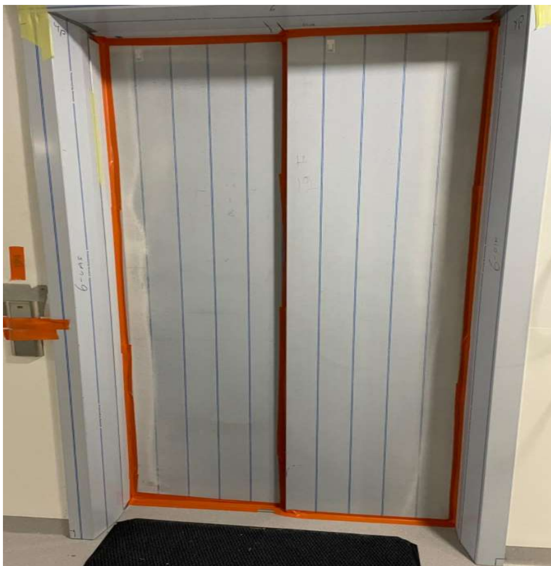
Kuva 9. Hissin ovien ilmarat teipattiin umpeen, jotta paine-ero ei tasoittuisi hissikuilun kautta.
