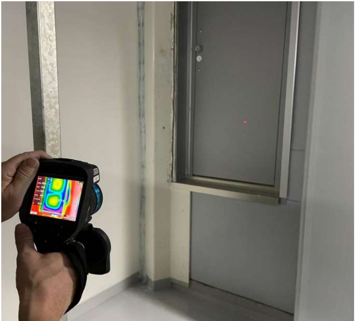
Kuva 15. Lämpökameralla nähtiin suoraan alueen kylmimmät kohdat.
