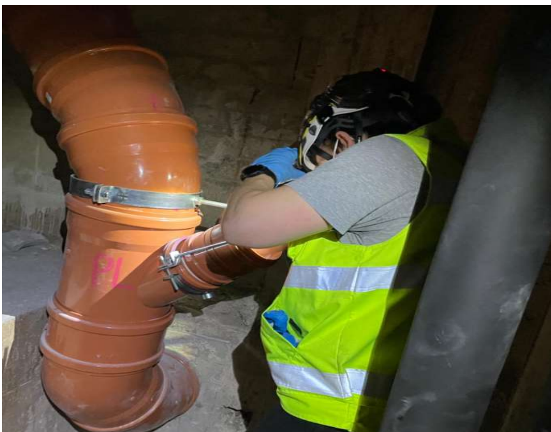
Kuva 10. Tiivistyspallo poistettiin viemäristä onnistuneen ulkovaipan vuotojen etsimisen jälkeen.
