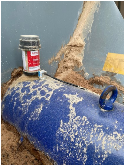
Kuva 11. Mittauspää kiinnitettyä puhaltimen väliakselissa. (Rossi, 2021)
