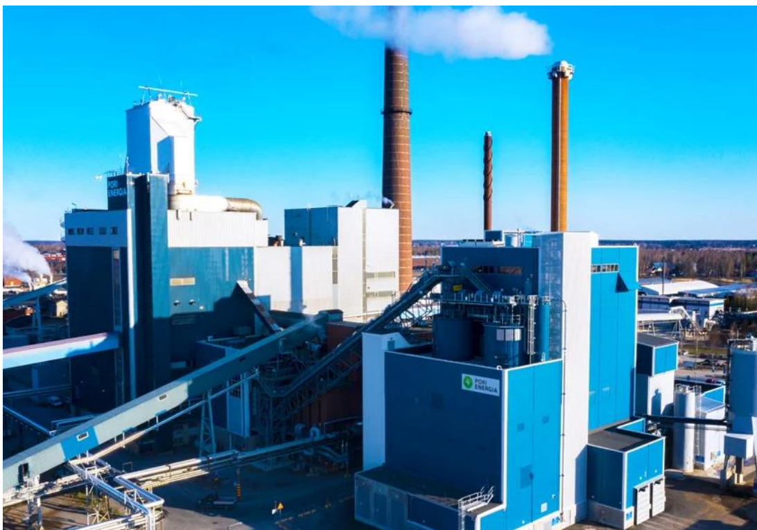
Kuva 1. Aittaluodon voimalaitos. (Insta Oy, 2020)
